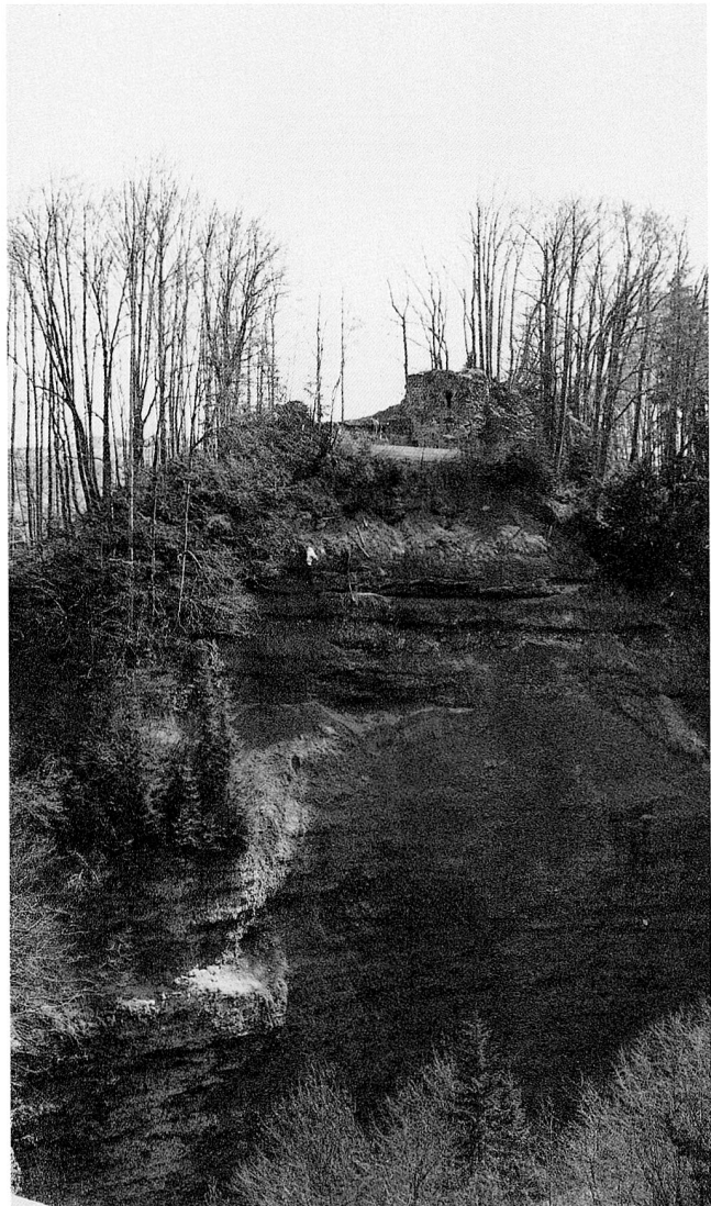
Abb. 1 Die Wildenburg von Nordwesten, Frühling 1985. Die schroffen Wände und der teilweise dichte Bewuchs stellen für die meisten Aufnahmeverfahren ein grosses Hindernis dar. Deutlich sichtbar ist die Betonplatte, die weitere Felsabbrüche verhindern soll. Der Vergleich mit Bildern von 1938 und 1972 lässt den Fortschritt der Erosion erahnen.
