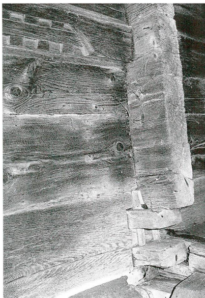
Abb. 9 Zweieren, Haus B. Östliche Traufseite, Erdgeschoss. Zweizungiges Schwellenschloss und Teil des Würfelfrieses (rechts oben). Zustand 1987.
