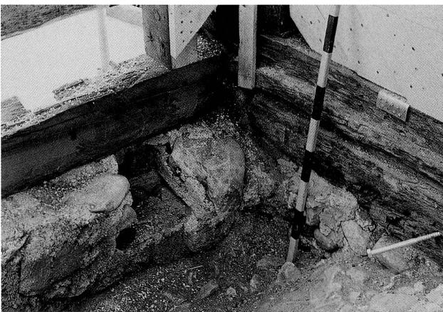
Abb. 5 Zug, Stolzengraben. Südwestzimmer im Erdgeschoss, Westecke. Auf der Krone der Südmauer (links) ist das Negativ eines Deckenbalkens der älteren Kellerdecke erhalten. Darin fand sich eine in Zürich geprägte Münze aus der Zeit um 1425. Rechts unten ist die Oberseite der Gewölbekalotte zu sehen.
