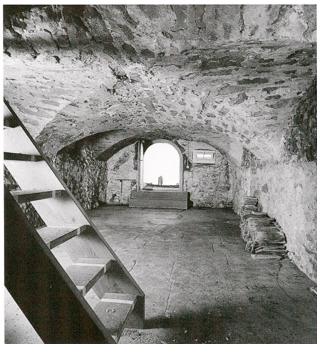
Abb. 25 Zug, Stolzengraben. Südlicher Keller, nach der Restaurierung. Blick nach Westen.
