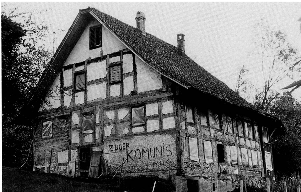
Abb. 1 Zug, Stolzengraben. Blick von Norden, Zustand 1996, vor der Restaurierung.
