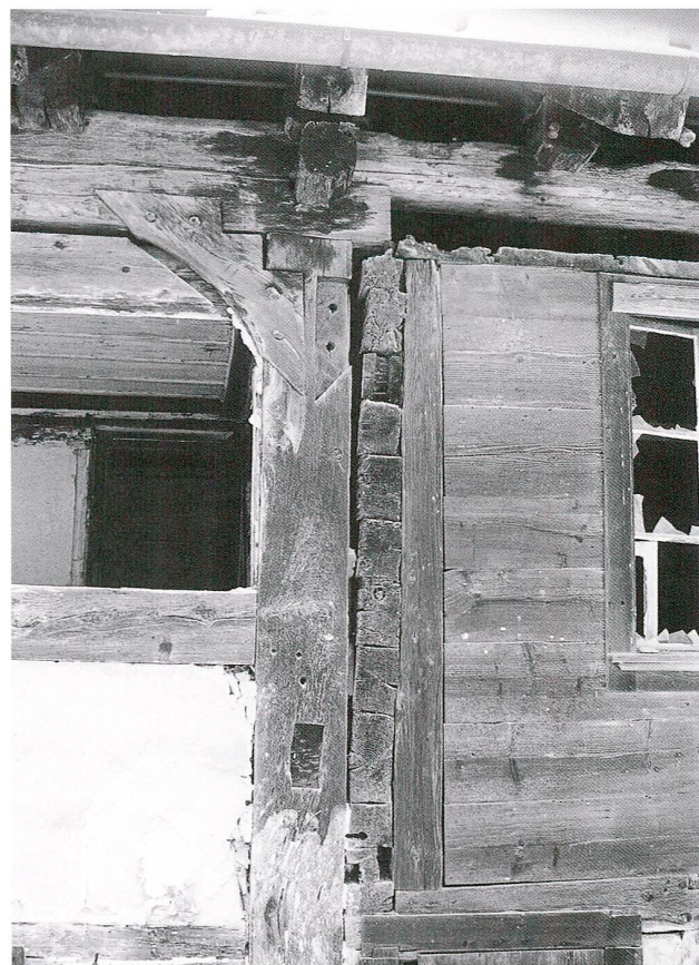
Abb. 18 Zug, Stolzengraben. Obergeschoss. Aussenseite, Blick Richtung Nordwesten. Ständerbau und nachträglich eingefügter Blockbauteil.
