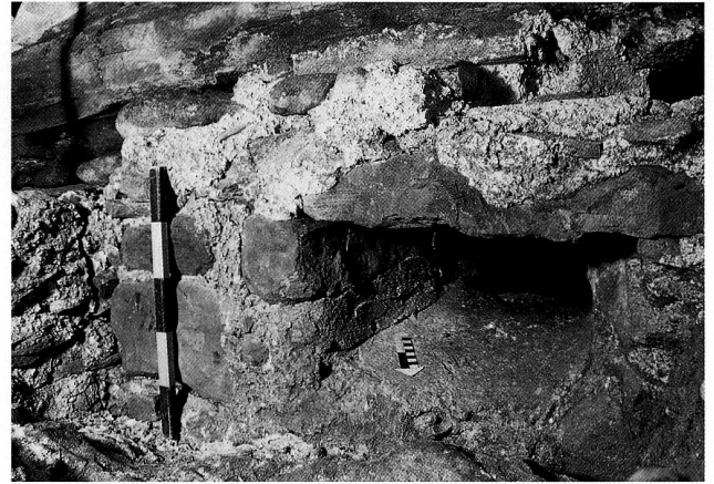
Abb. 4 Zug, Stolzengraben. Südmauer des Kellers, Innenseite. Fensterchen (vgl. Abb. 3) und Balkennegativ über dem Fenstersturz.
