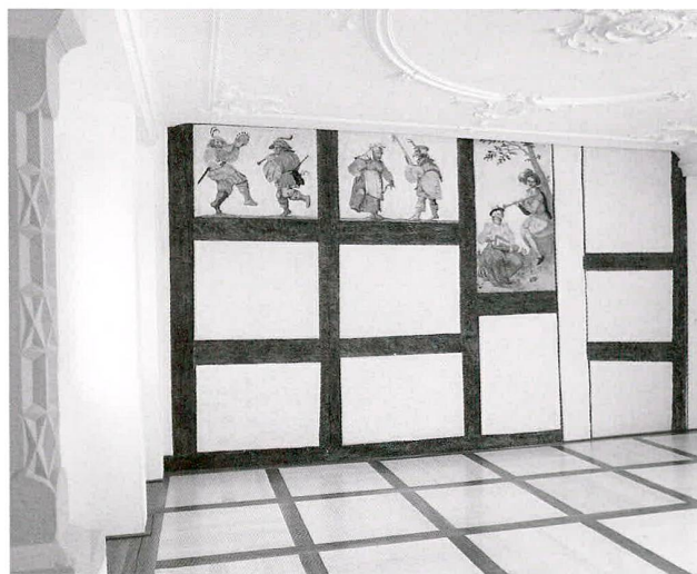
Abb. 29 Zug, Kolinplatz 5/7. Die Fachwerkwand mit den Malereien von ca. 1620.
