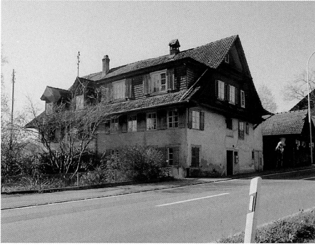
Abb. 10 Cham, Hünenbergerstrasse 43/45. Blick Richtung Südwesten. Zustand vor dem Abbruch Ende 1998.
