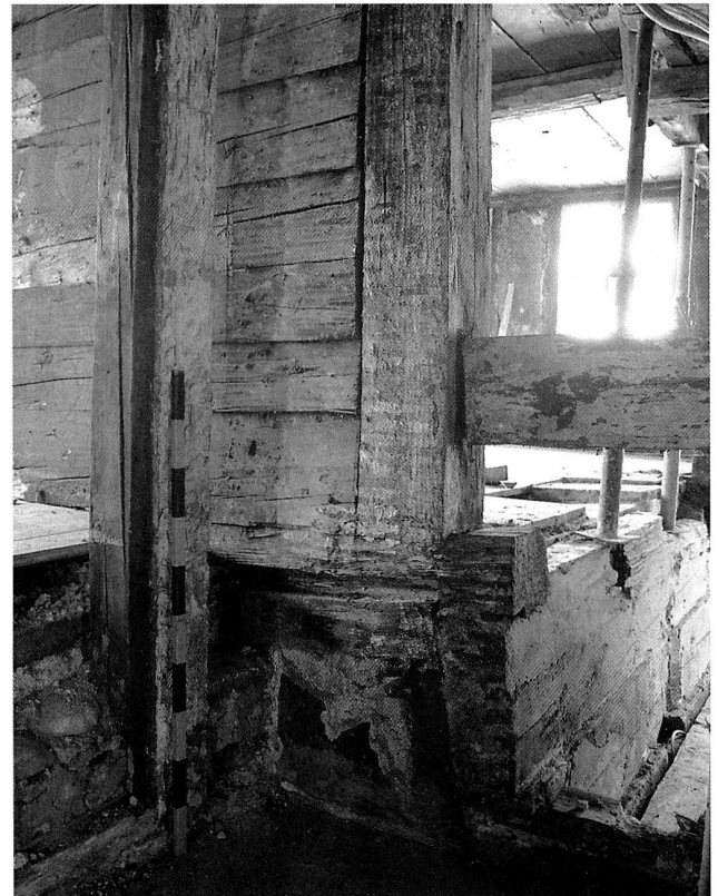
Abb. 4 Baar, Dorfstrasse 8. Der Mittelständer des Ständerbaus ist auf Teilen des Blockbaues platziert. Blick Richtung Nordosten.
