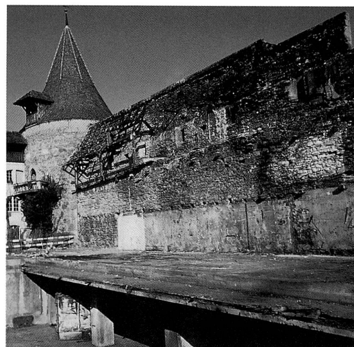
Abb. 12 Quartier Dorf, Blick Richtung Nordosten. Stadtmauer und Wehrgang, links der Knopfliturm, nach Entfernung des Brandschuttes.
