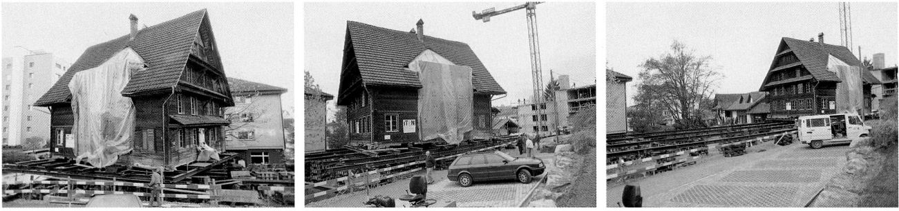
Abb. 15 Steinhausen, Bannstrasse 4. Verschiebung des Hauses.
