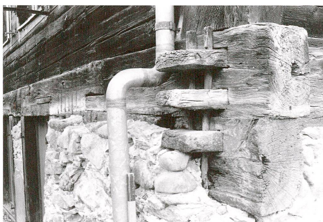
Abb. 14 Steinhausen, Bannstrasse 4. Schwellen mit dem zugehörigem Schloss an der Südostecke des Erdgeschosses, am oberen Bildrand der darauf stehende Ständer. Diese Bauteile wurden aus Eichen gefertigt, die gemäss ihrer dendrochronologischen Analyse 1315/16 geschlagen worden sind.
