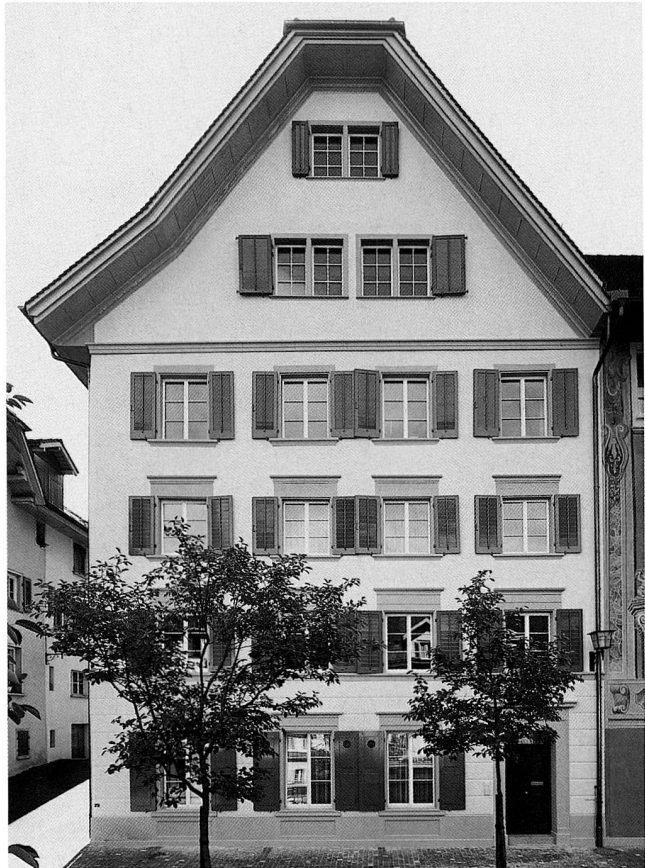
Abb. 1 Haus St.-Oswalds-Gasse 13, Westfassade. Nach der Restauration.
