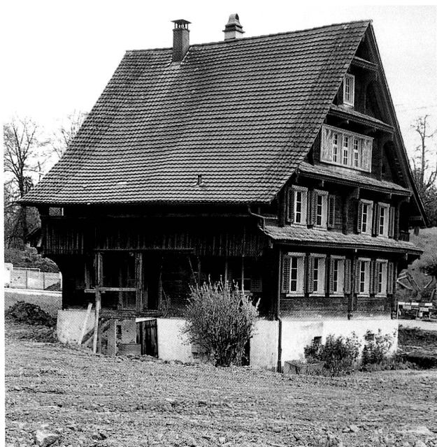
Abb. 29 Risch, Rischerstrasse, «Pächterhaus». Westliche Traufseite und Süd- fassade. Zustand April 2001.
