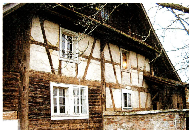
Abb. 13 Cham, Ochsenlon. Ostfassade mit jüngerem Riegelwerk. Ende 2001.
