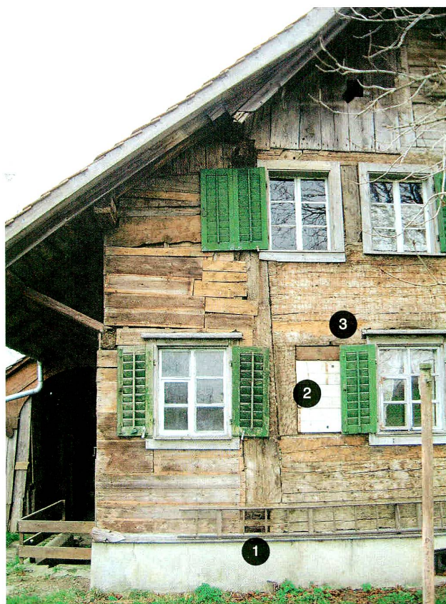
Abb. 14 Cham, Ochsenlon, Westfassade. 1 Schwellenschlösser des Kernbaues von 1681. 2 Reste der ursprünglichen Befensterung. 3 Loch für das Bedienungsband des Klappladens, mit dem man das Fenster verschloss.
