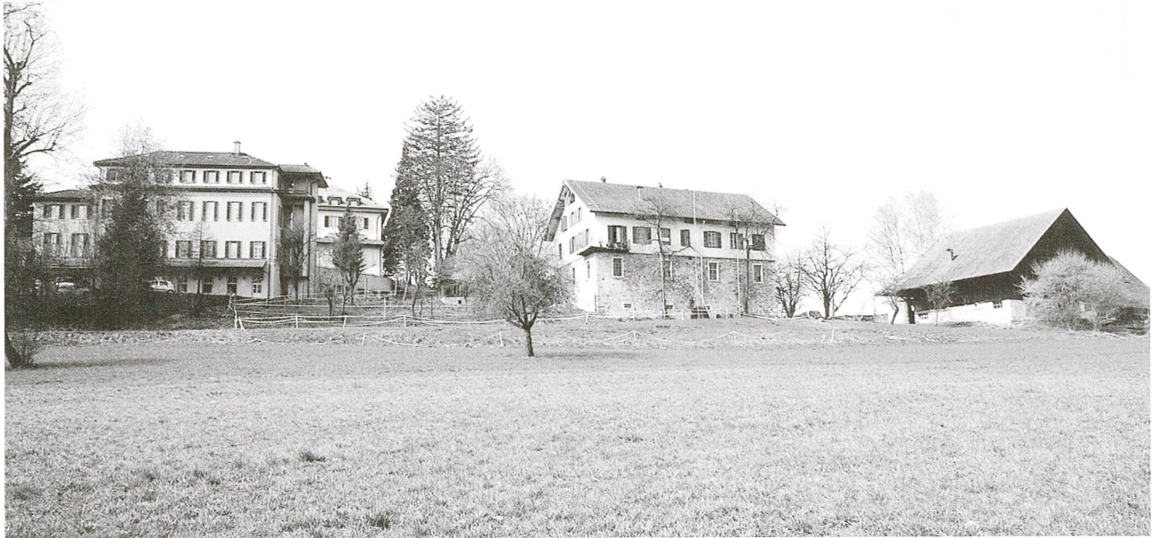
Abb. 32 Steinhausen, Schlossberg mit Schlosshof (Mitte) und zugehöriger Scheune (rechts) sowie Missionshaus (links). Blick Richtung Nordwesten, 2001.
