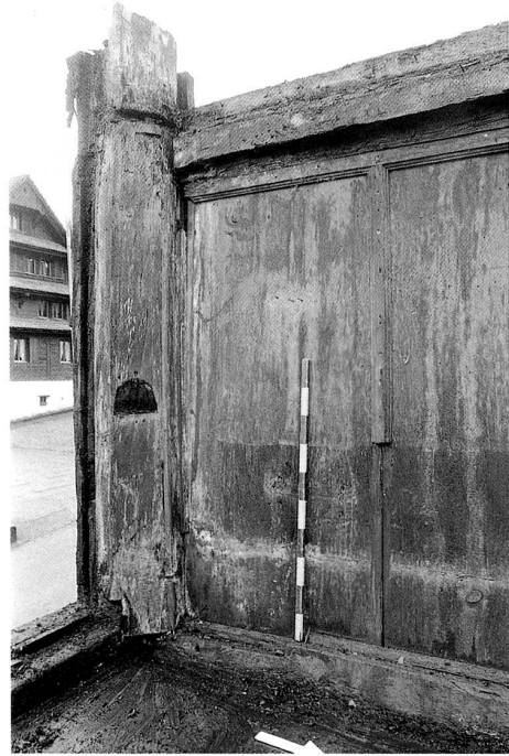
Abb. 25 Hünenberg, Dorfstrasse 8/10. Lehmfachwerk in der Ostfassade, Erdgeschoss.
