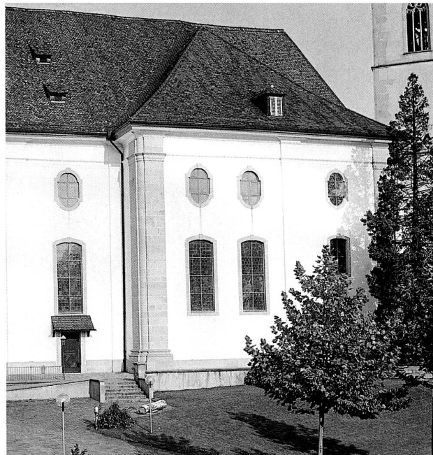
Abb. 17 Cham. Pfarrkirche St. Jakob. Bei der Renovation von 1962/63 verputzte man unter dem Titel der Materialechtheit sämtliche Fassadenteile, die nicht aus Sandstein bestehen, einheitlich weiss. Damit verloren die Fassaden ihre Feingliederung.
