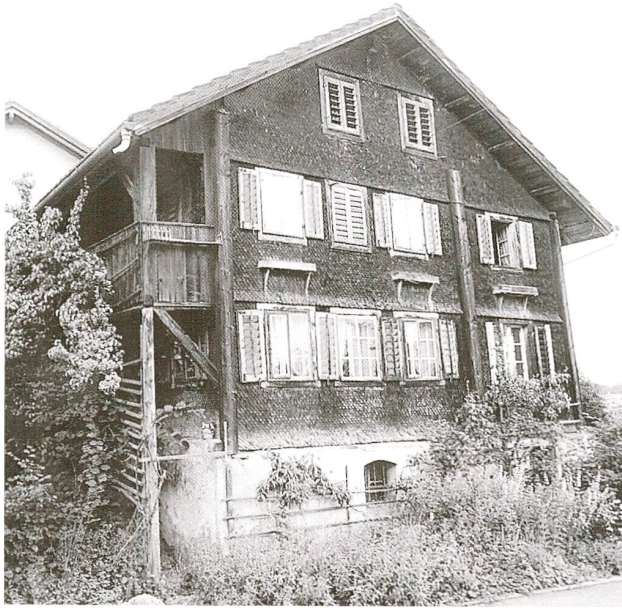
Abb. 30 Risch, Rotkreuz, Allrütliweg 5. Ostfassade, vor dem Abbruch im Juni 2001.
