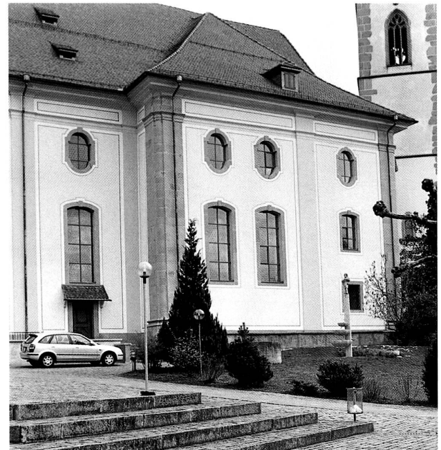
Abb. 18 Cham. Pfarrkirche St. Jakob. Bei der Aussenrestaurierung von 2001 erhielten die Fassaden ihr verlorenes, ursprüngliches Farbkleid zurück. Es wurde nach dem Bildokument von 1872 und aufgrund von bekannten Aussenfassungen auf Originalplänen und Bauten des Baumeisters Jakob Singer rekonstruiert.
