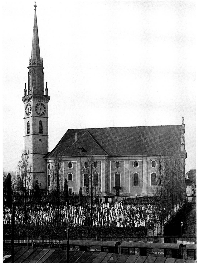
Abb. 16 Cham. Pfarrkirche St. Jakob. Bei der Renovation von 1904/05 behielt man das System der Fassadengliederung bei, gab ihm aber durch rauhen Verputz der Felder und stärkere Farbabstufungen eine kontrastreichere, neubarocke Wirkung.
