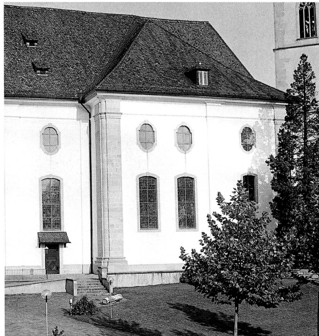
Abb. 17 Cham. Pfarrkirche St. Jakob. Bei der Renovation von 1962/63 verputzte man unter dem Titel der Materialechtheit sämtliche Fassadenteile, die nicht aus Sandstein bestehen, einheitlich weiss. Damit verloren die Fassaden ihre Feingliederung.
