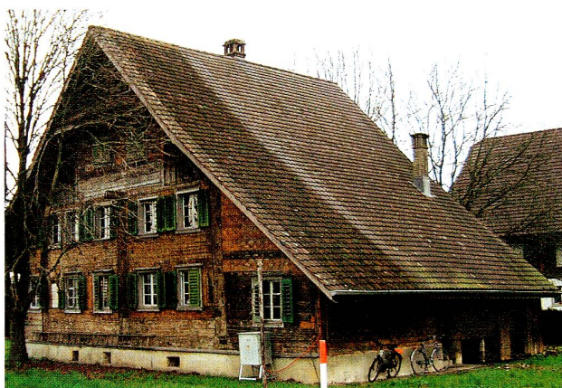
Abb. 12 Cham, Ochsenlon. Westfassade und südliche Traufseite nach der Abnahme von Verkleidungen. Ende 2001.
