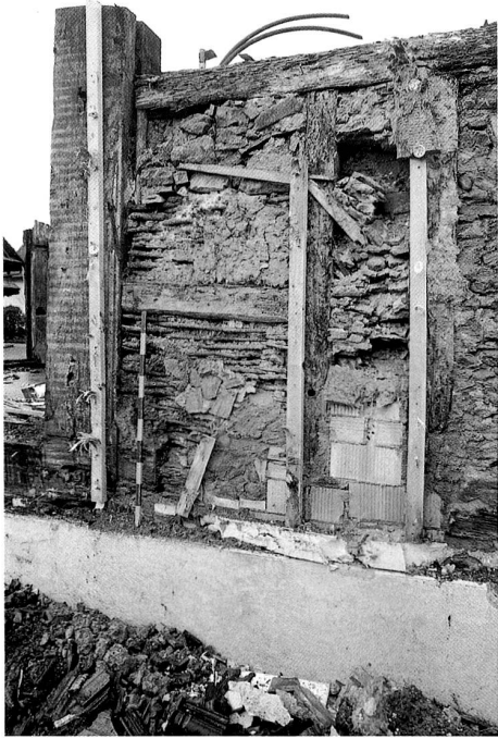
Abb. 25 Hünenberg, Dorfstrasse 8/10. Lehmfachwerk in der Ostfassade, Erdgeschoss.
