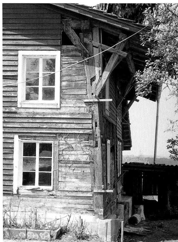
Abb. 20 Hünenberg, Burgstrasse 18, Südostecke. Unter Verbretterungen des 20. Jahrhunderts kamen der ursprüngliche Ständer und Teile der zugehörigen Wandfüllungen aus Bohlen zum Vorschein. Blick Richtung Norden, Juli 2000.
