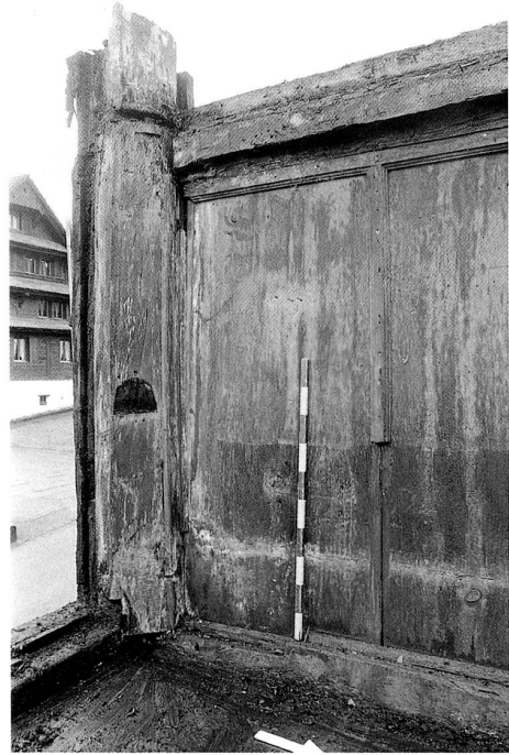
Abb. 25 Hünenberg, Dorfstrasse 8/10. Lehmfachwerk in der Ostfassade, Erdgeschoss.
