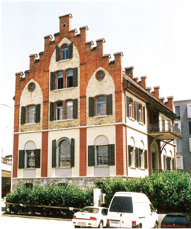
Abb. 19 Zug, Gotthardstrasse 31, Haus Felber. Westfassade, nach der Restaurierung.
