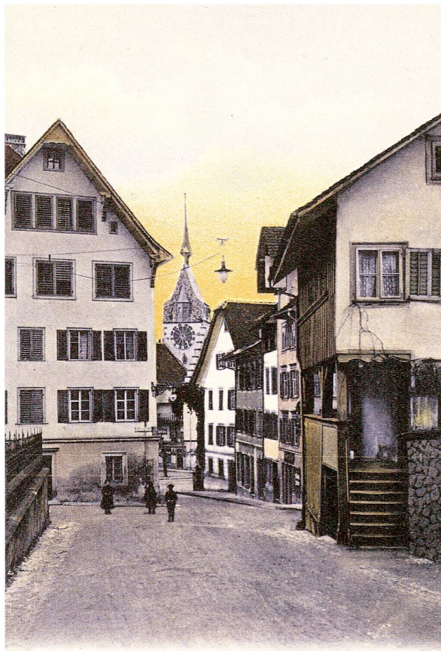
Abb. 31 Zug, St.-Oswalds-Gasse 5a, Pfrundhaus St. Anna. Ehemalige Aussen- treppe an der Südfassade.
