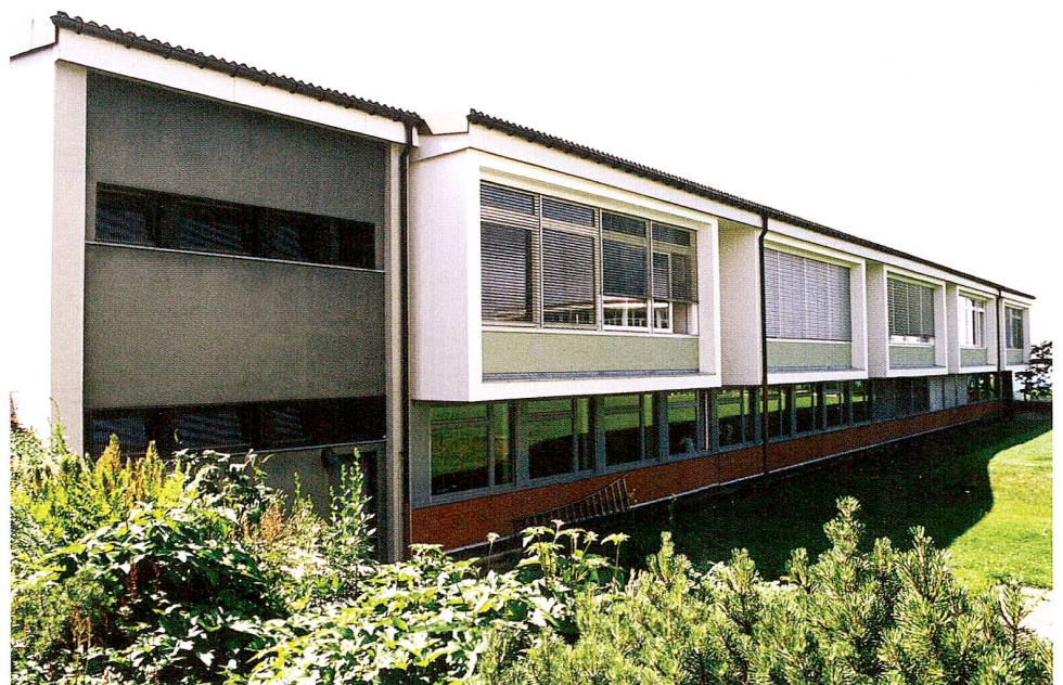
Abb. 13 Menzingen, Seminarstrasse 12, Lehrerinnenseminar Bernarda. Schulhaustrakt, Ostfassade.
