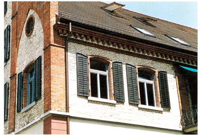
Abb. 20 Zug, Gotthardstrasse 31, Haus Felber. Südwestecke mit Metall- Jalousieläden, nach der Restau- rierung.
