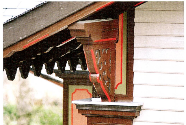
Abb. 5 Cham, Luzernerstrasse 35–41, «Kolonialstilhäuser». Eckkon- sole im Dachbereich, nach der Restaurierung.
