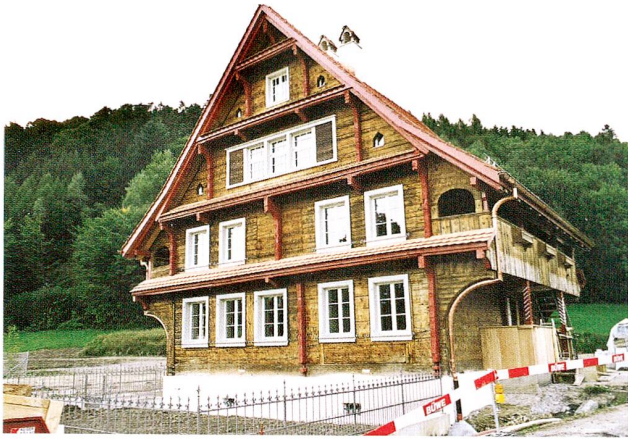
Abb. 15 Risch, Rischerstrasse, «Pächterhaus». Ansicht von Süden.
