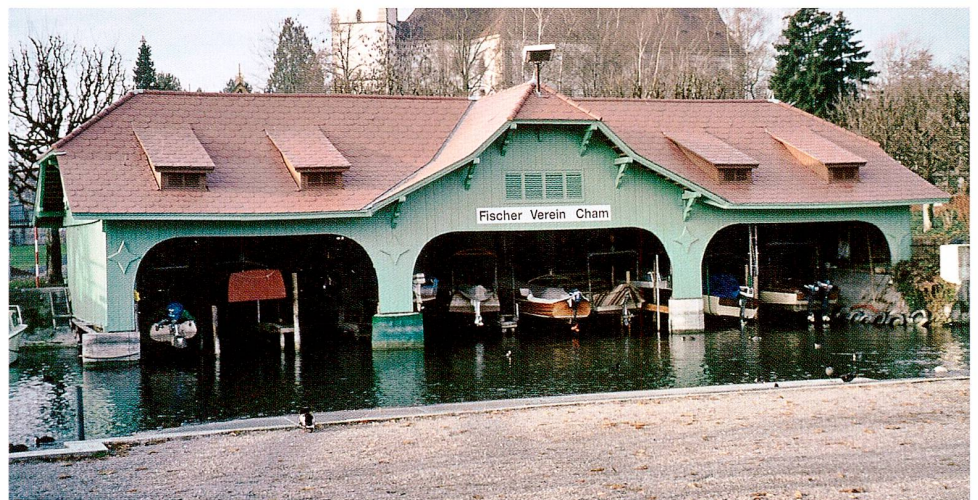
Abb. 10 Cham, Seestrasse, Bootshaus an der Lorze. Ansicht von Osten.
