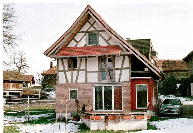
Abb. 19 Steinhausen, Erli, ehemaliges Wasch- und Brennhaus. Ansicht von Nordwesten.
