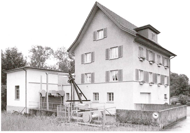
Abb. 5 Cham, Kloster Frauental, Verwalterhaus, Turbinenhaus und Wasserkraftanlage. Gesamtansicht von Nordwesten.
