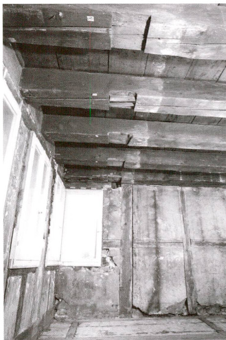
Abb. 29 Zug, Oberaltstadt 14, erstes Obergeschoss. Blick Richtung Süden. Deckenbalken mit Aussparungen für eine ehemalige Ostfassade. Die Spuren zeigen eine Auskrägung der Balken von ca. 80 cm.
