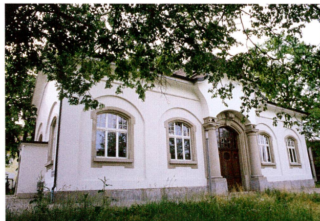
Abb. 4 Cham, Chirchbüel, ehemalige Sporthalle. Ansicht von Südosten.
