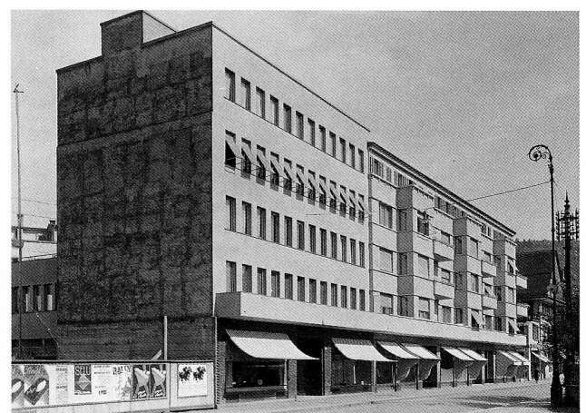
Abb. 17 Wohn- und Geschäftshaus Druckerei Kündig (Bundesplatz 10) von 1929/30 (links) und die südliche Verlängerung der Zeile (Bundesplatz 4–8) der Architekten Stadler & Wilhelm von 1930/31 (rechts). Die Zeile wird formal nicht gleich kompromisslos modern weitergeführt, trotzdem werden die Ladenfronten und die Balkonbrüstung beibehalten.
