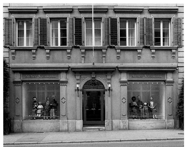
Abb. 4 Haus Neugasse 27 mit Ladeneingang und zwei Schaufenstern im Neurenaissancestil. Das rechte Fenster wurde erst 1927, das schon bestehende Fenster kopierend, ergänzt.
