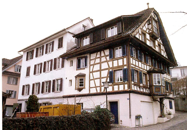
Abb. 39 Zug, Dorfstrasse 11, Wohnhaus. Westfassade des Hauses Dorfstrasse 11 (links), dessen Kernbau nicht vor 1558 erbaut wurde, und des Fachwerkhauses Dorfstrasse 9 (rechts), das vermutlich 1621 erbaut wurde. Nach dem Umbau.
