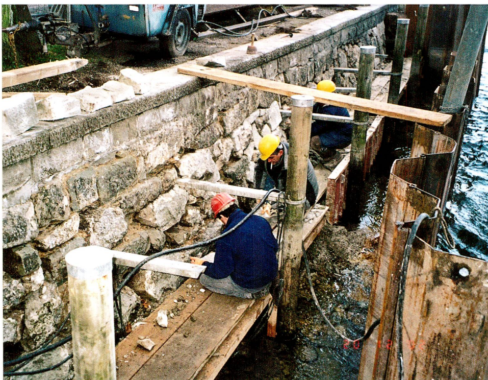
Abb. 41 Zug, Hechtleist bis Katastrophenbucht, Ufermauer. Sanierungsarbeiten. Ansicht von Westen.
