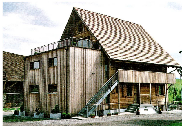
Abb. 15 Cham, Niederwil, Bauernhaus. Ansicht von Nordwesten.
