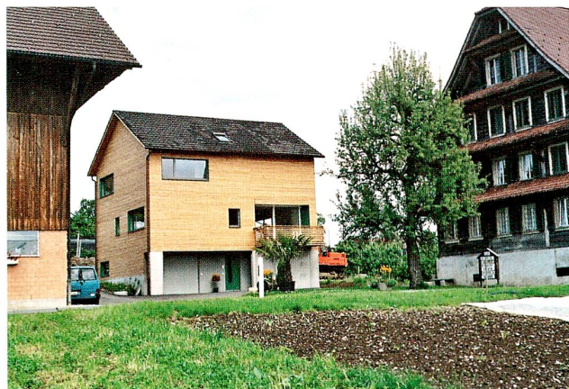
Abb. 17 Cham, Oberwil, Wohnhaus. Ansicht von Südwesten.
