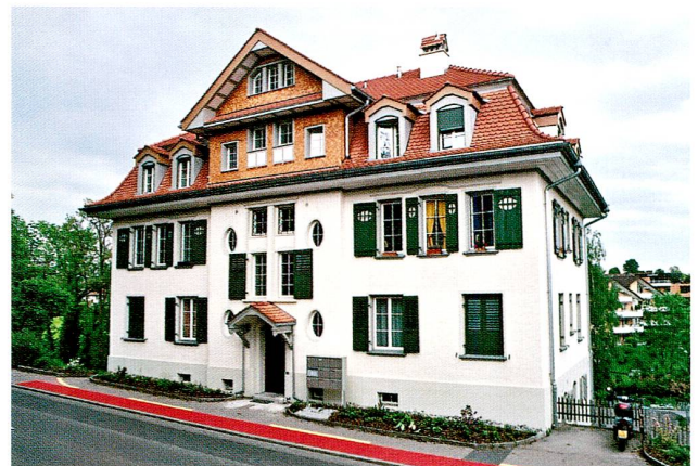
Abb. 20 Cham, Sinslerstrasse 16, Mehrfamilienhaus. Ansicht von Südwesten.
