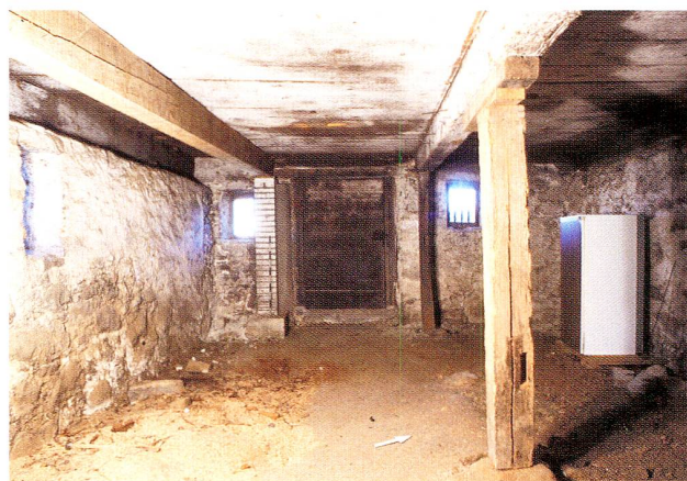
Abb. 7 Walchwil, Lauihof. Der grosse Keller (Raum 2). Blick nach Nordwesten.
