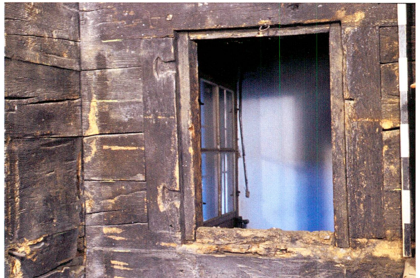
Abb. 10 Walchwil, Lauihof. Innenseite der Öffnung oder Durchreiche in der Wand zwischen Stube (Raum 6) und Quergang (Raum 7). Blick nach Nordosten.
