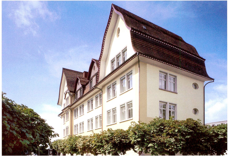
Abb. 35 Zug, Bundesstrasse 2, Schulhaus Neustadt. Ansicht von Nordosten.
