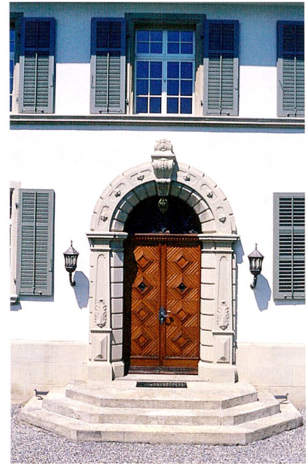
Abb. 40 Zug, Kirchenstrasse 17, Pfarrhaus St. Michael. Südwestfassade. Eingangsportal mit Rundbogen aus Sandstein.
