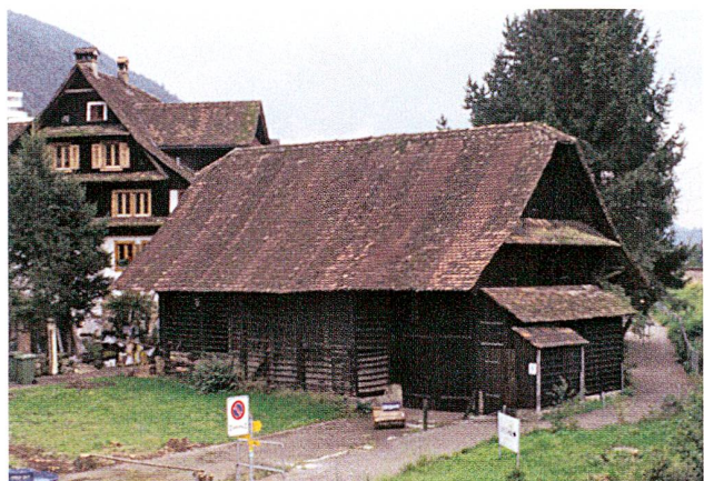
Abb. 48 Zug, Oberwil, Widenstrasse 14. Die im Jahr 2005 abgebrochene Scheune. Ansicht von Norden.
