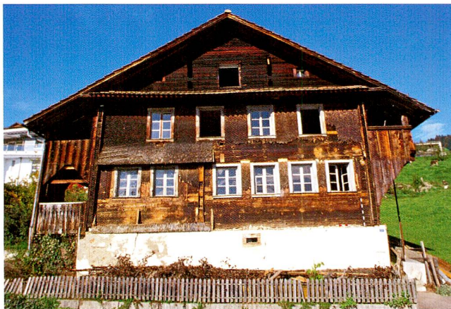
Abb. 10 Oberägeri, Grubenstrasse 37, Hintergrueben. Südfassade des um 1540 errichteten Blockbaus. Herbst 2006.
