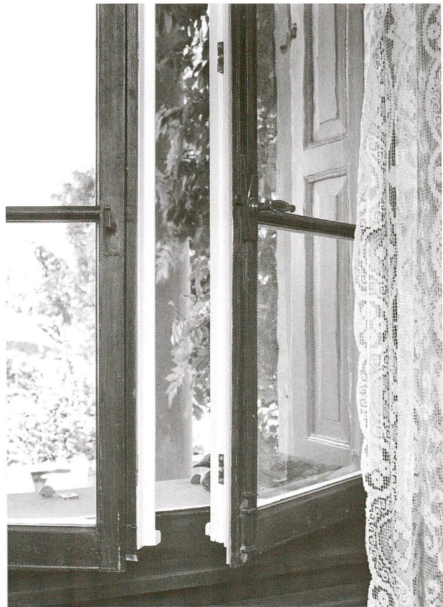
Abb. 35 Zug, Artherstrasse 6, Villa Unterer Frauenstein. Fensteraufdoppelung, Detail.
