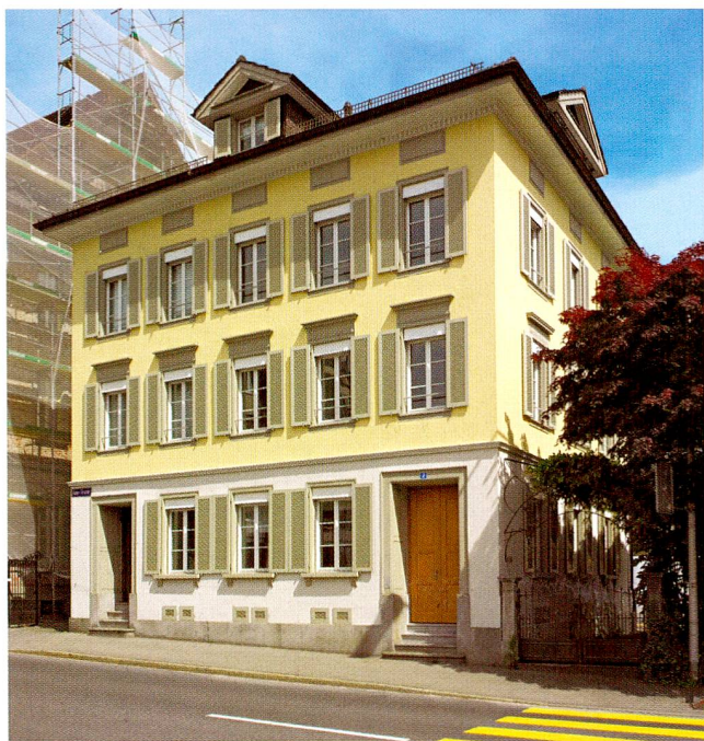
Abb. 29 Zug, Alpenstrasse 2, Wohn- und Geschäftshaus. Aussenansicht.
