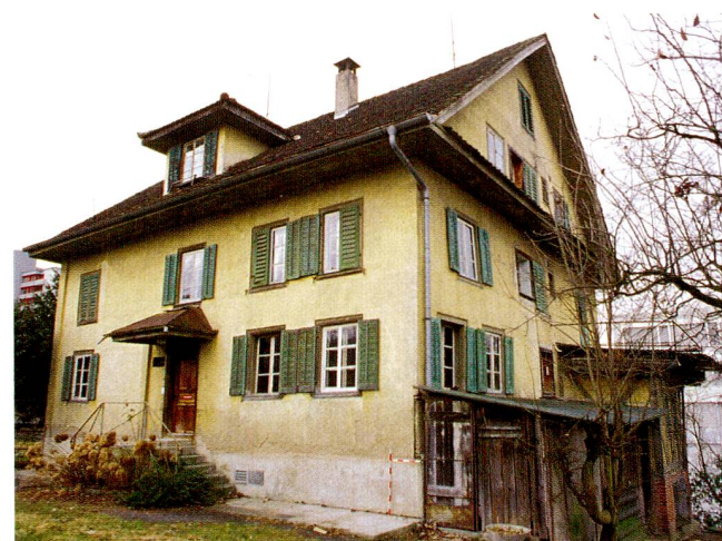
Abb. 30 Zug, Alte Baarerstrasse 7. Das Haus vor dem Abbruch 2006, Blick nach Süden. Im Vorderteil links der Türe verbargen sich Reste eines Blockbaus, vermutlich von 1593.
