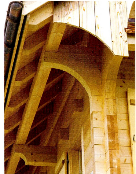
Abb. 18 Oberägeri, St. Jost. Bruderhaus. Detail der Holzkonstruktion.
