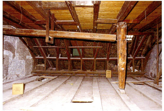
Abb. 52 Zug, Zeughausgasse 21. Der mächtige, frühestens 1704 erbaute Dachstuhl mit der Aufzugswinde. Übersicht nach Westen.
