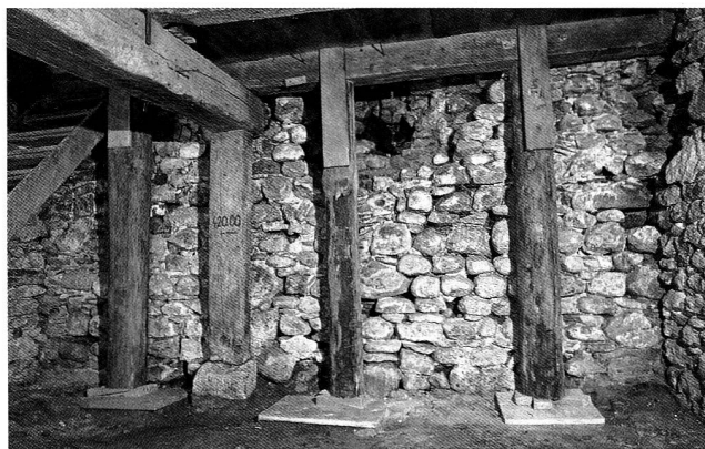
Abb. 14 Ansicht an die innere Grabengegenmauer im Keller von Haus Graben 10. Blick nach Nordosten.
