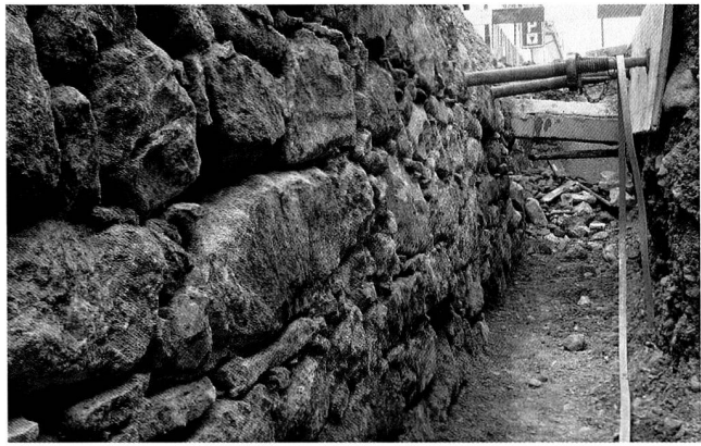
Abb. 20 Innere Grabengegenmauer am Nordende der Grabenstrasse. Blick nach Süden. Leitungssanierung 1988.
