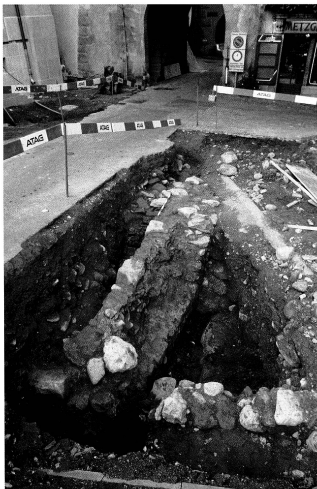
Abb. 16 Die innere Grabengegenmauer und die westliche Wange der gemauerten Grabenbrücke vor dem Zitturm. Blick nach Südwesten.
