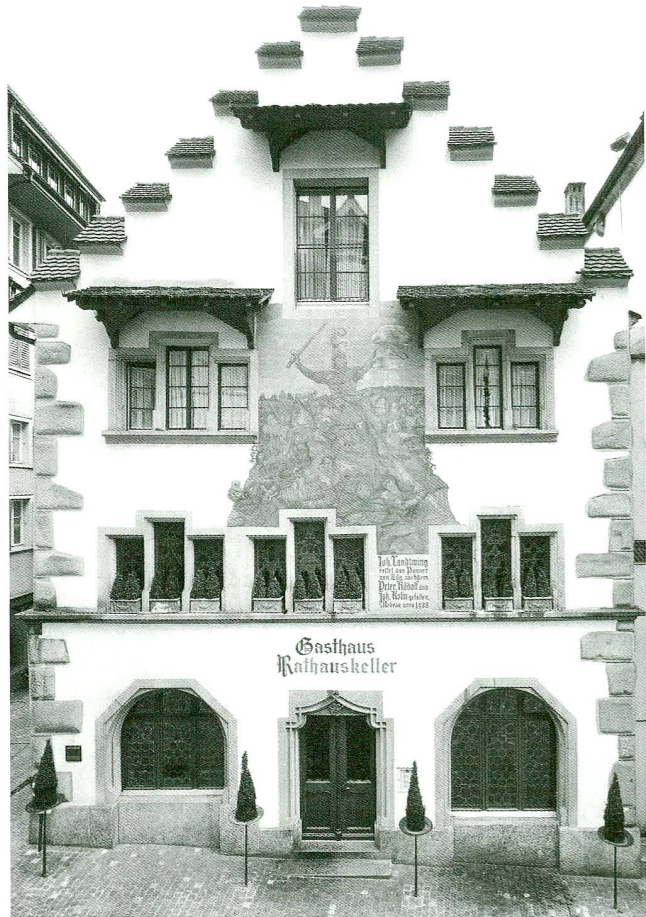
Abb. 7 Rathauskeller in Zug. Die Nordfassade vor der Restaurierung. Aufnahme 2002.
