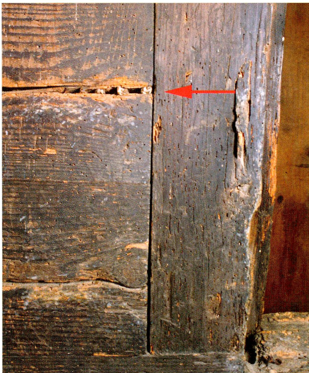
Oberägeri, Eggstrasse 57, Haltenbüel. Der rote Pfeil weist auf eine Reihe von Zähnen in einem Schwundriss unmittelbar neben dem Wandschrank («Pestfenster»).
