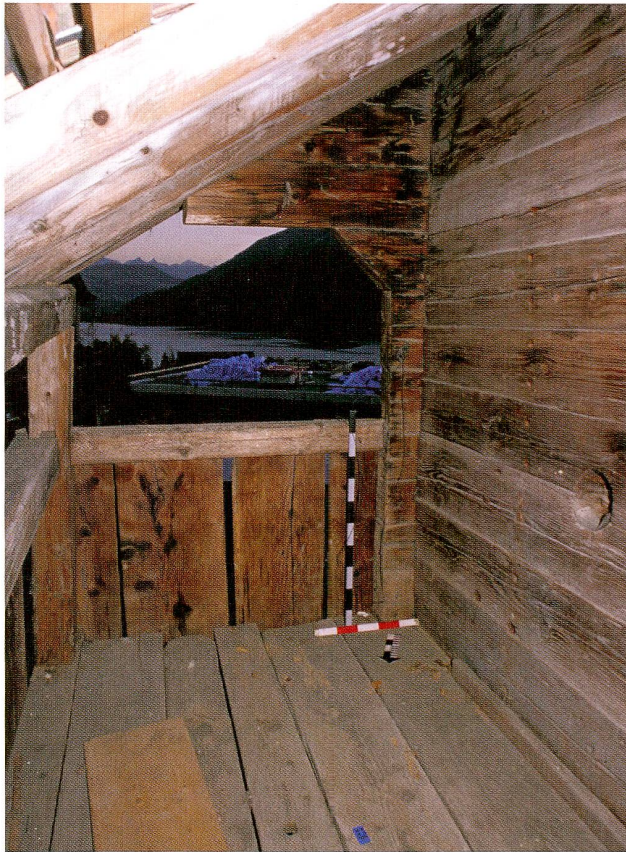
Abb. 11 Oberägeri, Hintergrueben. Zweites Wohngeschoss, östliche Laube. Auf die gleiche Art, wie die oben sichtbaren, über die Fassadenflucht vorkragenden Balken den äussersten Rafen abstützen, waren auch die Auflieger der Laube gefertigt. Vorne rechts das in die Blockwand gesägte Loch einer jüngeren Aufzugswelle, dahinter eine senkrechte Reihe mit Zapflöchern für einen Zettelrahmen.
