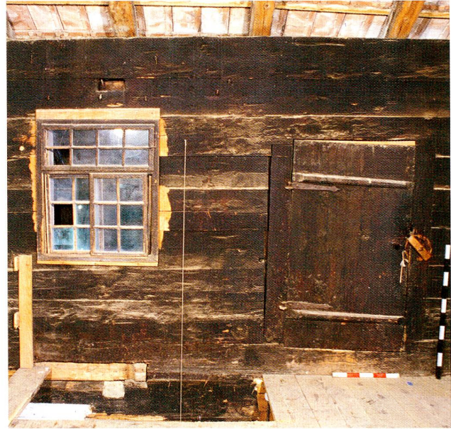
Abb. 10 Oberägeri, Hintergrueben. Zweites Wohngeschoss, Nordteil (Raum 10). Ostfassade (Innenseite) mit originalem Türgericht und Türblatt des Ausgangs zur Laube. Die beiden Türpfosten sind etwa 8 cm tief ins Sturzholz eingeschnitten. Links der Türe ein ehemaliges, wieder verwendetes Stubenfenster aus dem 18. Jahrhundert.
