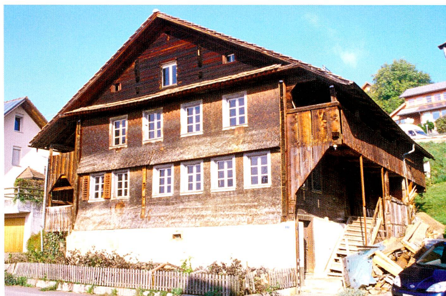
Abb. 2 Oberägeri, Hintergrueben. Giebelseite des dreigeschossigen Gebäudes. Das steinerne Sockelgeschoss wurde als Keller genutzt, der Zugang in die Wohnräume führte über eine Laube auf der rechten Seite.
