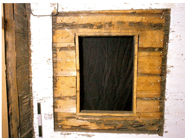
Abb. 8 Oberägeri, Hintergrueben, Eingangsbereich (Raum 3). Nordseite der Binnenwand zur Stube. In der Mitte ist die rechteckige Öffnung des Wandschranks in der Stube («Pestfenster») zu sehen, darum herum das Negativ des dazugehörigen Kastens mit horizontalen Abdrücken der Tablare.
