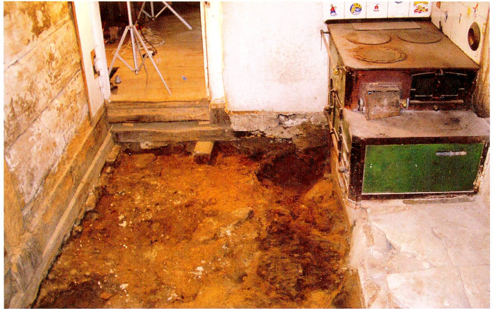
Abb. 14 Oberägeri, Hintergruben. Küche (Raum 6). Rechts der eiserne Sparherd aus der Zeit um 1900, darunter der gemauerte Sockel einer älteren Herdstelle. Im Vordergrund das ca. 30 cm tiefer liegende, ältere Bodenniveau.
