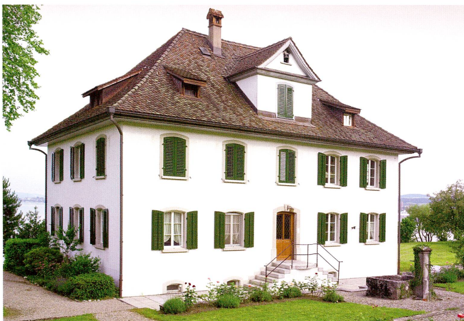
Abb. 34 Zug, Artherstrasse 33, Unterer Roost, Herrschaftshaus Fideikommiss Müller. Ansicht von Osten.
