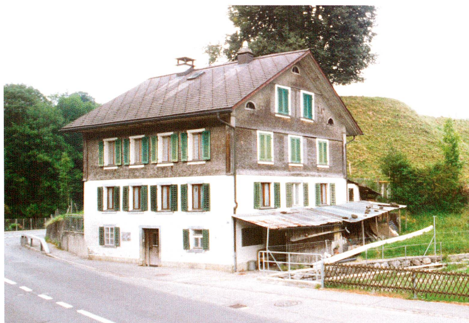
Abb. 19 Menzingen, Neuägeri, Zugerstrasse 148, Wohnhaus. Das 2007 abgebrochene Haus neben dem Teuftännlibach.
