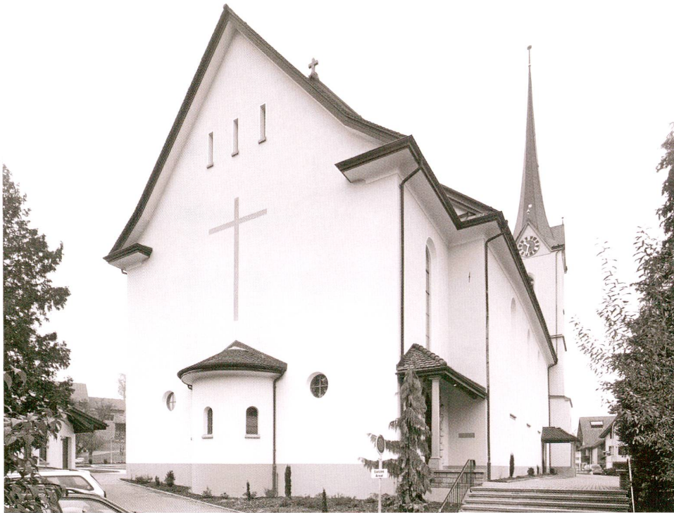
Abb. 21 Menzingen, Pfarrkirche St. Johannes der Täufer. Ansicht von Südwesten.
