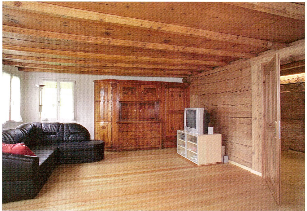
Abb. 27 Unterägeri, Unterblacki. Stube, nach der Restaurierung.
