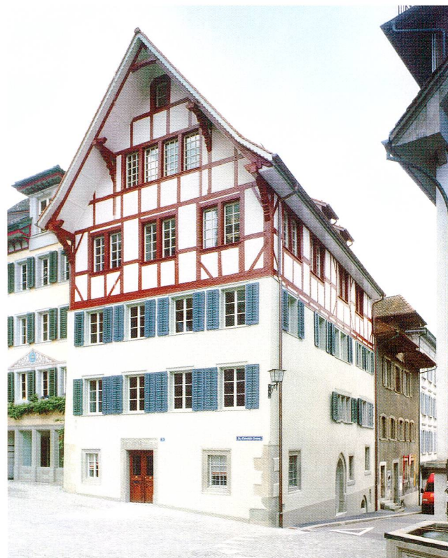
Abb. 47 Zug, St.-Oswalds-Gasse 10. Aussenansicht.
