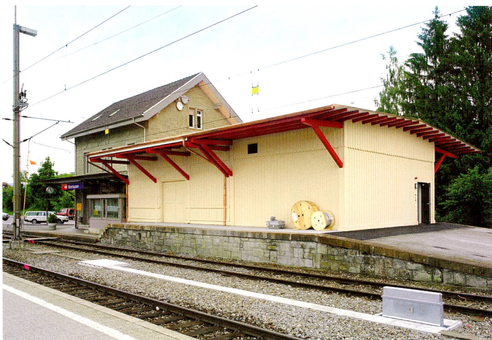
Abb. 18 Steinhausen, Bahnhofgebäude. Erweiterung Lagerschuppen. Ansicht von Süden.
