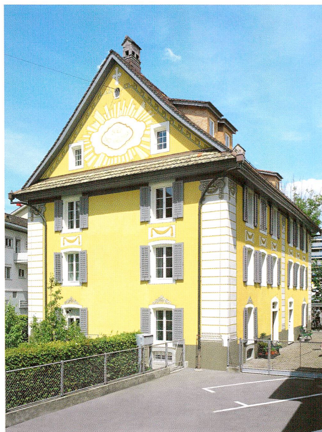
Abb. 6 Baar, Zugerstrasse 1, Pfrundhaus Reidhaar. Ansicht von Süden.
