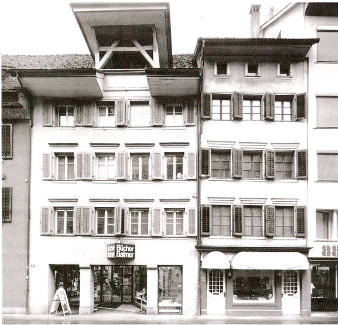
Abb. 39 Zug, Neugasse 10 und 12. Ostfassaden. Im Haus Neugasse 12 (links) befinden sich Reste eines spätmittelalterlichen Blockbaus. Aufnahme 2006.
