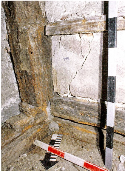
Abb. 7 Zug, St.-Oswalds-Gasse 10. Erstes Obergeschoss, Raum 10, Südwestecke. Der originale Ständer ist mit Fase und auslaufendem Schildchen verziert. Er ist in die südliche Ausschwelle (links) eingezapft, in welche die westliche Innenschwelle (rechts) stösst. Die Deckenbretter laufen unter der Innenschwelle durch, in der Ausschwelle sind sie eingefalzt. Über der Oberkante des bereits entfernten Mörtelgusses sind die Nuten zur Aufnahme der Bodenbretter sichtbar.
