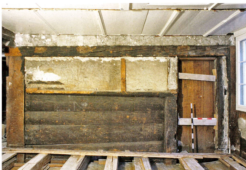
Abb. 5 Zug, St.-Oswalds-Gasse 10. Zweites Obergeschoss, Raum 19, Blick nach Westen. Zum Originalbestand gehören fünf Wandbohlen, Süd- und Nordständer (nur wenig sichtbar), Türpfosten, Wandrähm und Bundbalken. Die Wandbohlen sind im Süden (links) in den Ständer eingemutet. Die oberste und unterste Bohle zogen ursprünglich durch den Türpfosten hindurch bis in die Nut des Nordständers. Auf der obersten Bohle sitzt das Wandrähm, auf dem ehemals die Bodenbretter des Dachgeschosses auflagen. Die Ständer, die oben durch einen Bundbalken abgeunden sind, ragten ursprünglich als sogenannter Kniestock in dieses Geschoss hinein.
