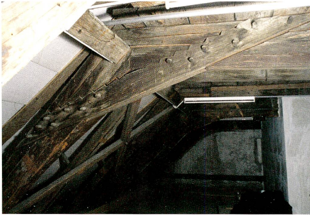
Abb. 40 Zug, Ägeristrasse 5. Der 1499 errichtete liegende Dachstuhl, Blick nach Westen.
