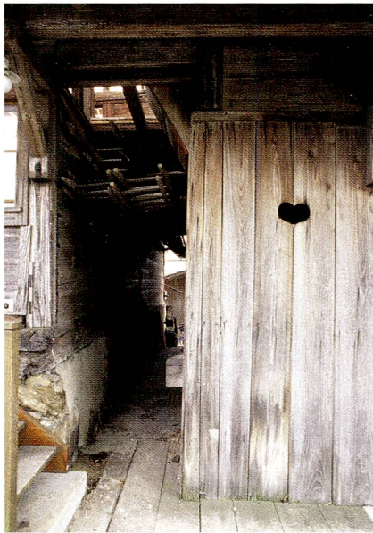
Abb. 8 Cham, Oberwil 24, Hof. Der 1 m breite Zwischenraum zwischen den beiden Hausteilen, Blick nach Osten. Rechts im Vordergrund ein jüngerer Abortanbau.
