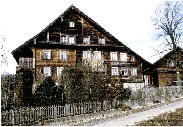
Abb. 26 Risch, Berchtwil 2. Doppelwohnhaus, dessen Osthälfte (rechts) archäologisch untersucht wurde. Ansicht von Süden.
