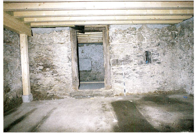
Abb. 28 Risch, Berchtwil 2. Keller unter dem Vorderhaus. Ostmauer mit horizontaler Bauweise oberhalb der Mitte. Das untere Mauerwerk stammt vermutlich von 1529, die Aufmauerung von 1576.
