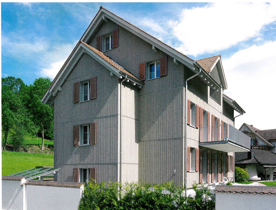
Abb. 38 Unterägeri, Zugerstrasse 183a, Wohnhaus. Ansicht von Nord- westen.
