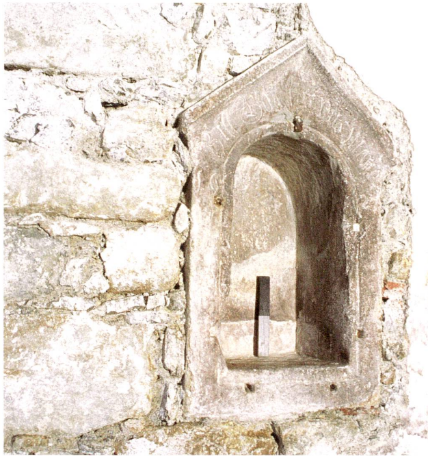
Abb. 51 Zug, Hofstrasse 42, Oberer Roost, Wohnhaus. In der nördlichen Kellermauer des Anbaus war ein Bildstock von 1627 eingemauert.
