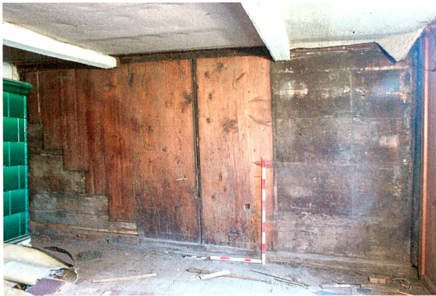
Abb. 15 Baar, Leihgasse 39/41. Hinter dem Wandtäfer der Stube im westlichen Hausteil kam kurz vor dem Abbruch die im Fundzustand nur schwer erkennbare Bohlenmalerei zum Vorschein. Blick nach Osten.
