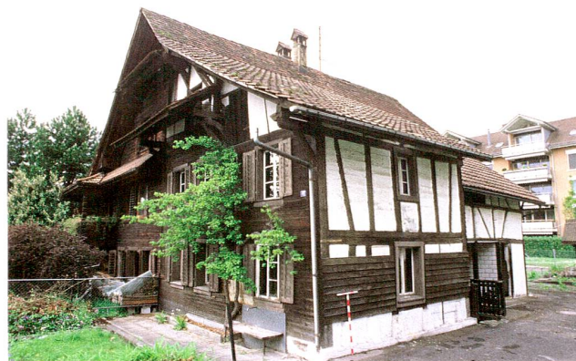
Abb. 11 Baar, Leihgasse 39/41. Der 1664/65 errichtete Ständerbau vor dem Abbruch im Jahr 2010. Blick nach Nordwesten.
