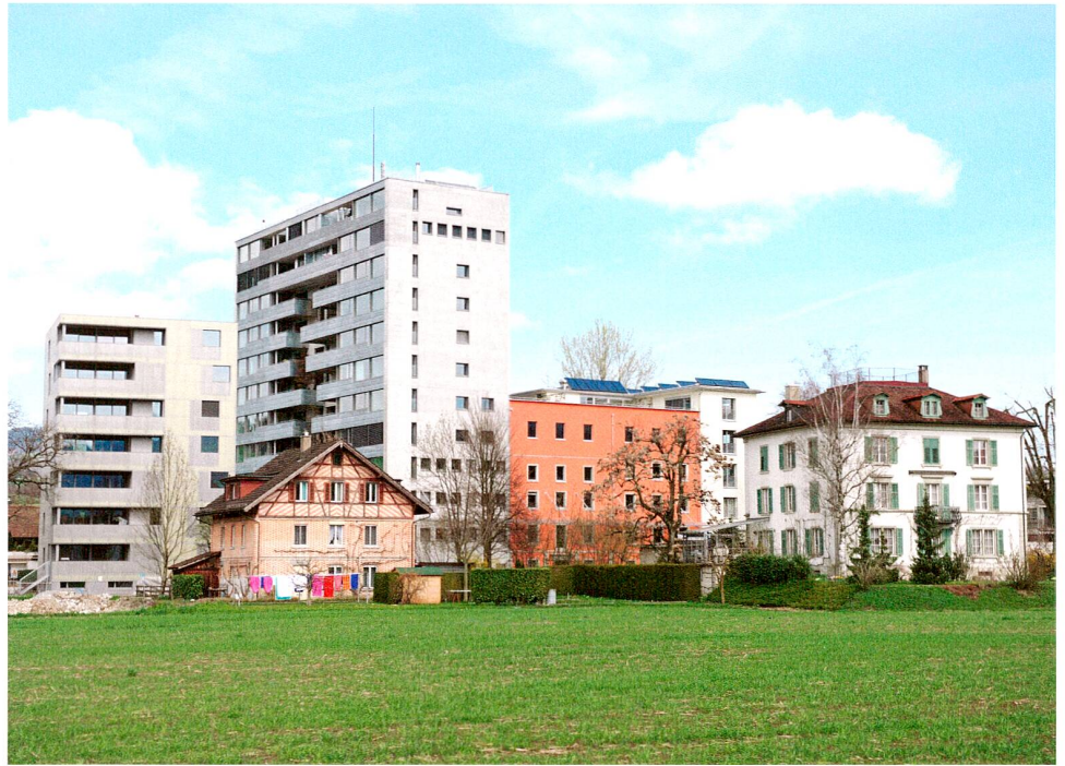
Abb. 19 Baar, Obermühle, ehemaliger Getreidesilo. Ansicht von Süden.
