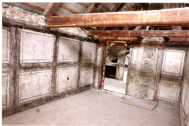
Abb. 4 Baar, Allenwinden, Dorfstrasse 5, Gasthaus Adler. Südöstliche Kammer im unteren der zwei Dachgeschosse. Blick nach Südwesten. Die Spuren an der Westwand stammen vom Kamin über dem Kochherd. In der Türschwelle eine Aussparung für eine Fachwerkstrebe, auf die wegen der Lage des Kaminhuts noch während des Baus verzichtet worden ist. Die Türe war ursprünglich rechts davon geplant.
