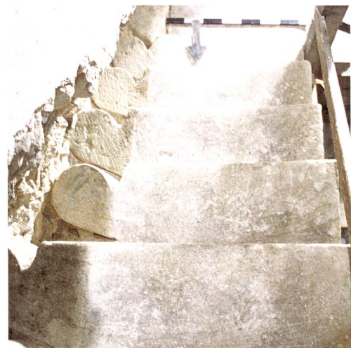
Abb. 50 Zug, Hofstrasse 42, Oberer Roost, Wohnhaus. Stufen einer älteren Wendeltreppe bildeten die Stufen der jüngeren Kellertreppe.
