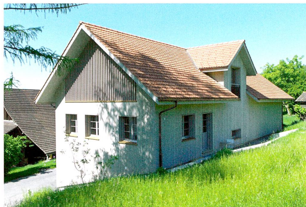
Abb. 9 Baar, Bofeld 2, Ökonomiegebäude. Ansicht von Nordosten.
