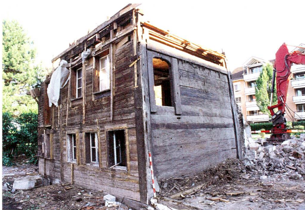
Abb. 13 Baar, Leihgasse 39/41. Beim Abbruch des Hauses wurde der Bohlenständerbau von 1419 freigelegt und komplett geborgen.
