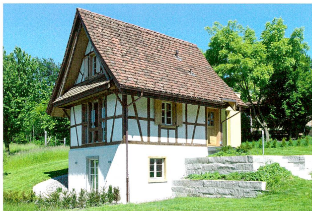
Abb. 8 Baar, Bofeld 4, ehemaliges Dörrhaus. Ansicht von Südosten.
