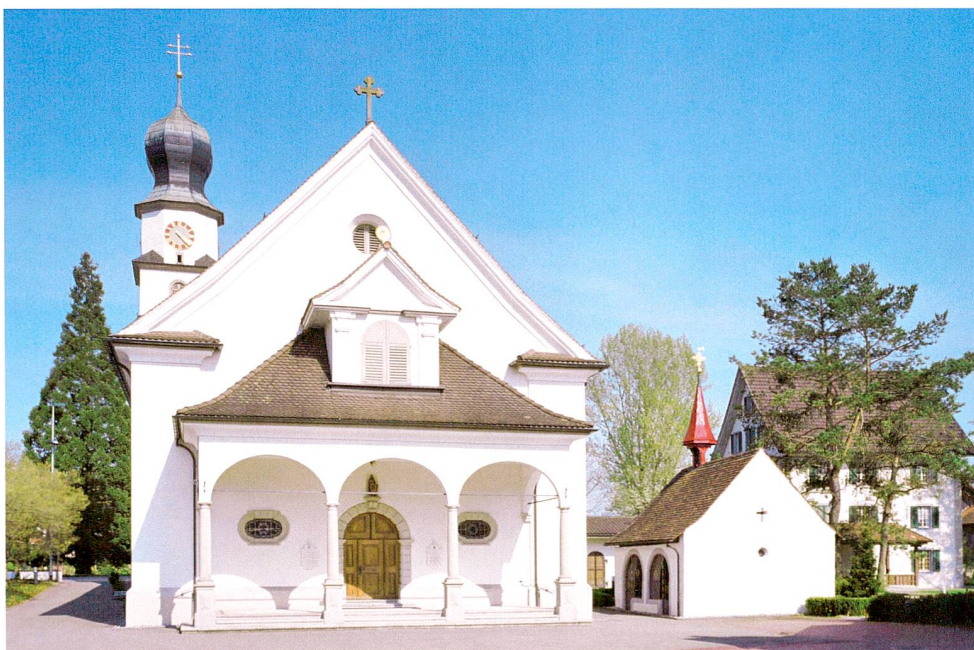
Abb. 1 Steinhausen. Pfarrkirche St. Matthias und Beinhaus «Unserer Lieben Frau». Die heutige Kirche wurde 1913/14 neu gebaut. Ansicht von Westen, vor den Baumassnahmen von 2011/12.
