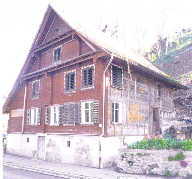
Abb. 48 Walchwil, Zugerstrasse 38, Wohnhaus. Das um 1788 erbaute und 2012 abgebrochene Haus. Ansicht von Südwesten.
