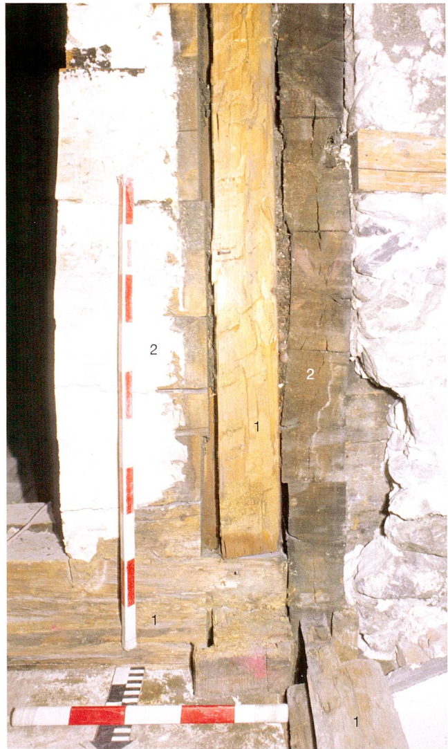
Abb. 55 Zug, Neugasse 10, Wohn- und Geschäftshaus. Erstes Obergeschoss, Südwestecke der Stube. 1 Schwellen und Ständer des 1501 errichteten Bohlenständerbaus Neugasse 10. 2 Vorstösse und Balken des kurz nach 1491 errichteten, südlich benachbarten Blockbaus Neugasse 12. Blick nach Süden.
