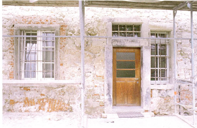
Abb. 15 Cham, Kloster Frauental. Ostflügel, Ostfassade. Untersuchung der Fassaden im März 1997. Unter dem Fenster links der Backsteinboden für die ehemalige Abortanlage.
