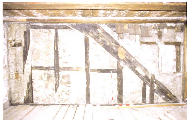
Abb. 56 Zug, Neugasse 10, Wohn- und Geschäftshaus. Drittes Obergeschoss, Ostraum. Teile des 1501 errichteten Dachstuhls wurden im 17. Jahrhundert in eine in Fachwerkbauweise erfolgte Aufstockung integriert. Blick nach Norden.
