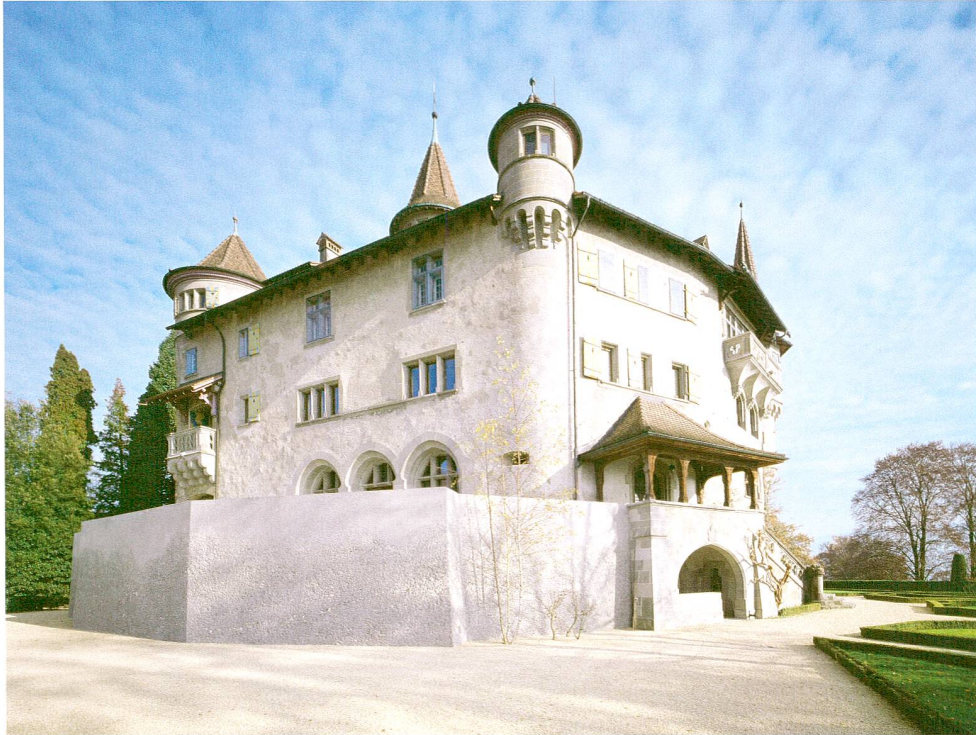
Abb. 20 Cham, St. Andreas I, Schloss St. Andreas. Terrassenanbau von 2010/11. Ansicht von Südwesten.
