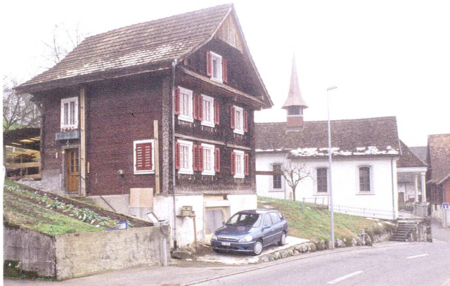
Abb. 47 Walchwil, Vorderbergstrasse 20, Wohnhaus. Der kleine, im frühen 19. Jahrhundert errichtete Blockbau nördlich der Kapelle St. Antonius im Oberdorf.
