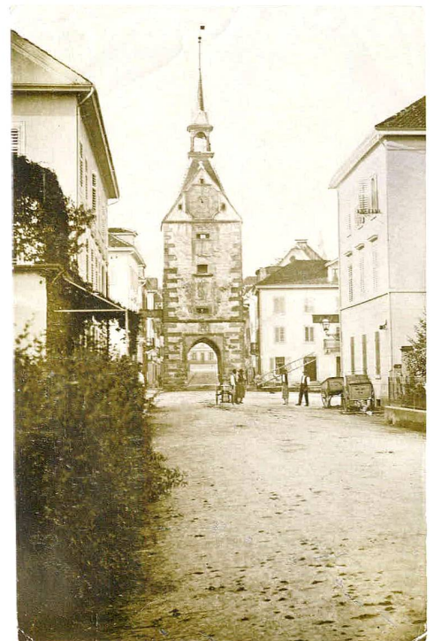
Abb. 33 Anonym, Baarertor kurz vor dem Abriss, 1873. Die Glocke und die Uhrzeiger sind bereits entfernt.
