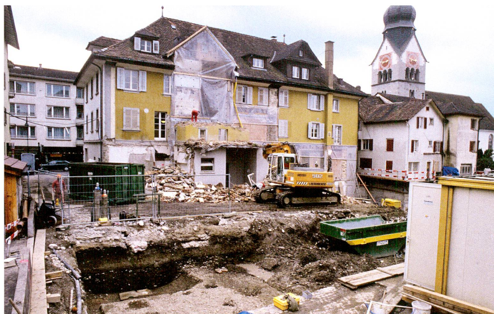
Abb. 4 Baar, Dorfstrasse 38/40. Schwierige Grabungsbedingungen im Hinterhofareal des Lindenhofs. Blick nach Süden auf Feld B, im Hintergrund der Kirchturm von St. Martin.
