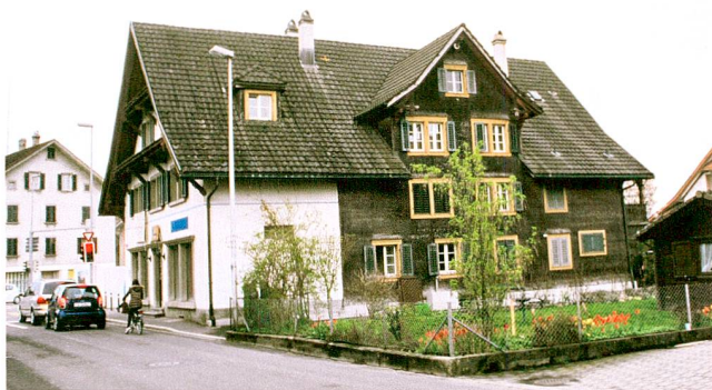
Abb. 6 Baar, Büelstrasse 1, Wohnhaus «Büelegg». Das 2012 abgebrochene Haus bestand im Westteil (rechts) aus einem Ständerbau von 1717/18 und einem Anbau an der Ostseite von 1927/28. Blick nach Süden.
