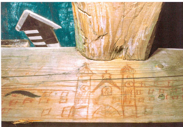
Abb. 14 Baar/Menzingen, Lorzentobelbrücke. Historische Rötelzeichnung an der nördlichen Fusspfette. Ansicht einer Klosterfassade (vermutlich Rheinau).
