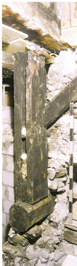
Abb. 53 Zug, Grabenstrasse 10, Wohnhaus. Der dendrochronologisch ins Jahr 1374/75 datierte Ständer mit der zugehörigen Strebe in der Südfassade war der letzte Rest des Dachstuhl des Bohlenständerbaus. Blick nach Südwesten.
