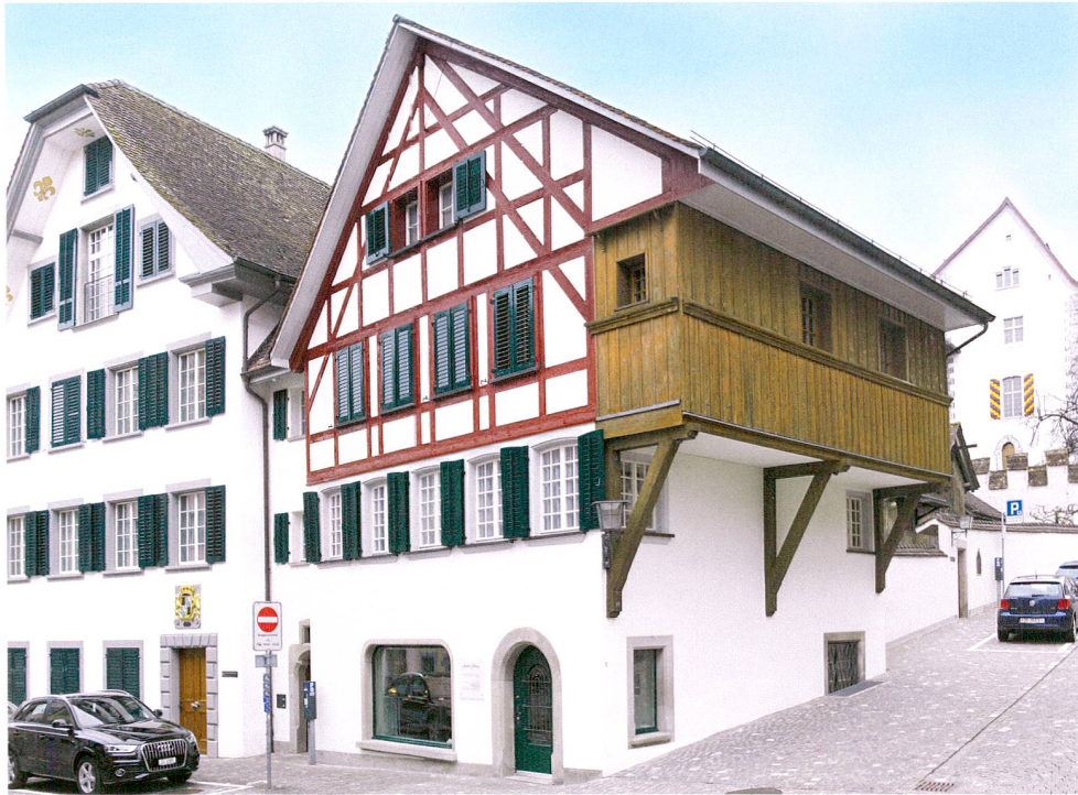
Abb. 61 Zug, St.-Oswalds-Gasse 5a, Pfrundhaus St. Anna. Ansicht von Westen.
