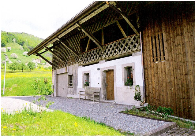
Abb. 43 Walchwil, Forchwaldstrasse 4, Scheune. Aussenansicht von Nordwesten.
