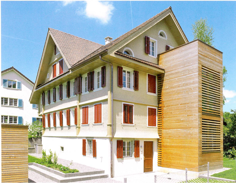
Abb. 56 Zug, Löberenstrasse 34, Wohnhaus. Ansicht von Westen.
