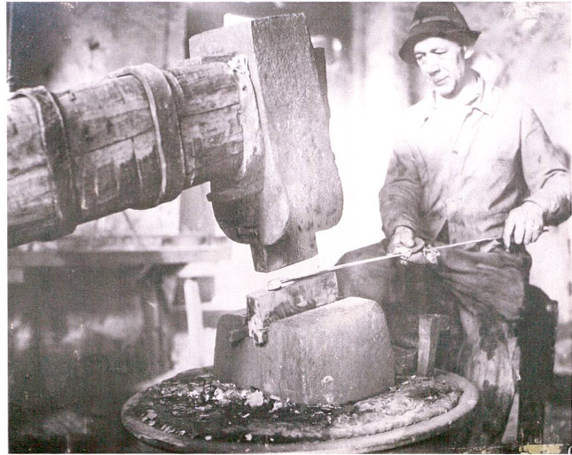
Abb. 4 Sensenschmied an der Arbeit mit einem mechanischen Schmiedehammer. Man beachte das Grössenverhältnis zwischen Mensch und Hammerkopf. Die grössten Hammerköpfe waren bis zu 300 Kilogramm schwer und verursachten mit jedem der rasch und regelmässig aufeinander folgenden Schläge einen ohrenbetäubenden, weithin hörbaren Lärm. Die Positionierung des Werkstücks, z. B. des Sensenblatts, unter dem Hammer war sehr heikel. Ein Fehlschlag machte nicht nur die bisherige Arbeit, sondern das ganze Werkstück unkorrigierbar zunichte. Sensenschmiedemuseum Micheldorf (Oberösterreich).
