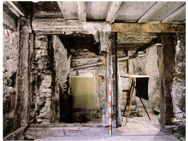
Abb. 10 Zug, Haus Dorfstrasse 6/8. Westwand des südöstlichen Raums. Blick von Südosten.
