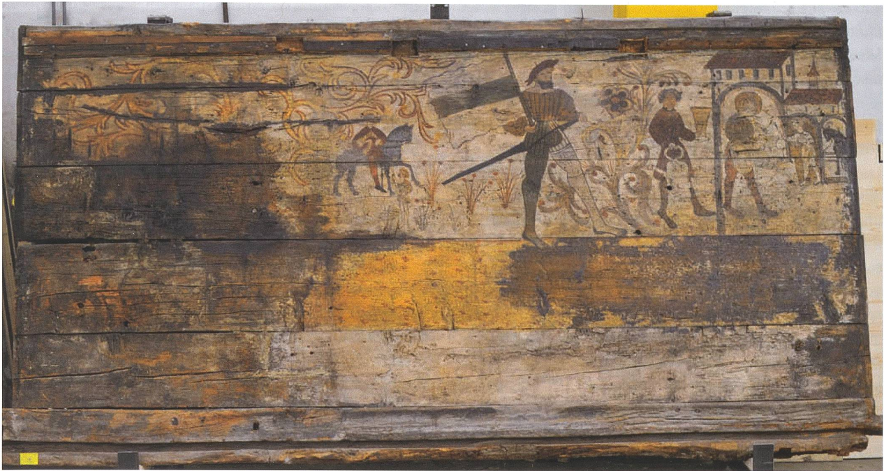
Abb. 10 Baar, Leihgasse 39/41. Ostwand nach der Restaurierung.
