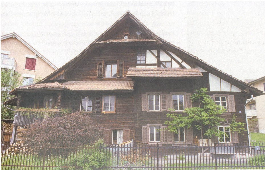
Abb. 1 Baar, Leihgasse 39/41. Das Wohnhaus stand im Quartier Langgass, östlich ausserhalb des Zentrums von Baar.
