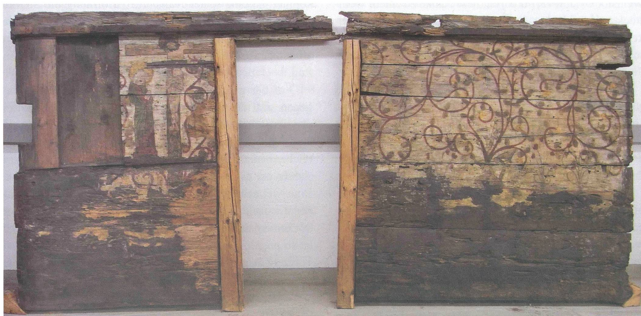
Abb. 8 Baar, Leihgasse 39/41. Westwand nach der Restaurierung.
