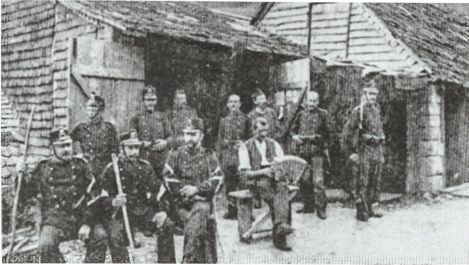
Abb. 8 Unteroffiziersposten des Landwehrebataillons 142 in Gwidem bei Langenbruck (Baselland), 1915.
