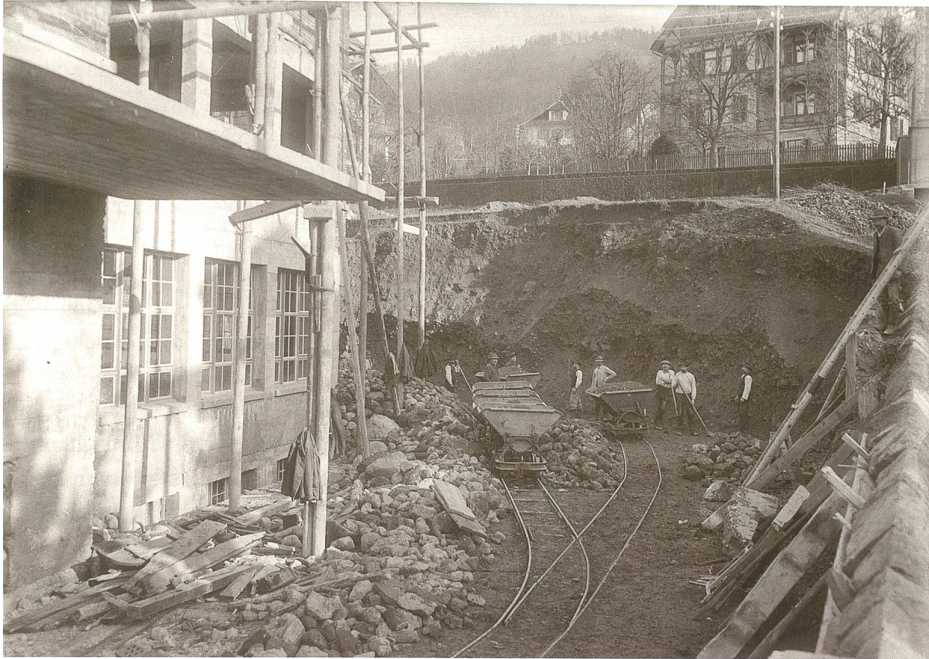
Abb. 3 Erstellung des Hochbaus im Süd- areal des Landis & Gyr-Werks Hofstrasse. Baustelle und Werk- geleise. 1916.
