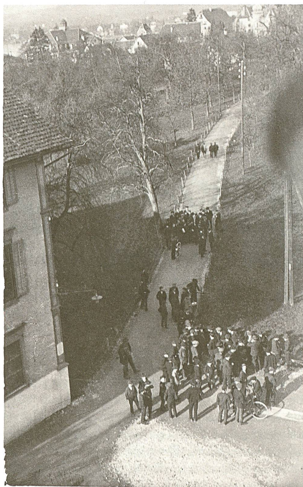
Abb. 12 Arbeitsbeginn im Landis & Gyr-Werk Hofstrasse. 1918.
