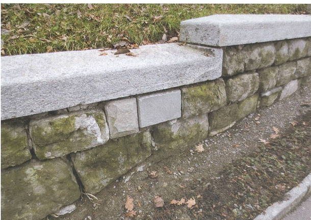
Abb. 45 Zug, Pfarrkirche St. Michael. Umfassungsmauer. Saniertes Mauerstück. Ansicht von Westen.
