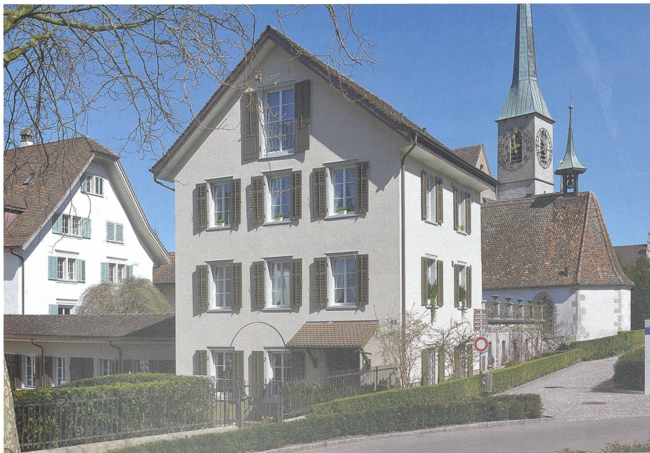
Abb. 51 Zug, St.-Oswalds-Gasse 19, St.-Petrus-Claver-Sodalität, Wohn- und Geschäftshaus. Ansicht von Süden.
