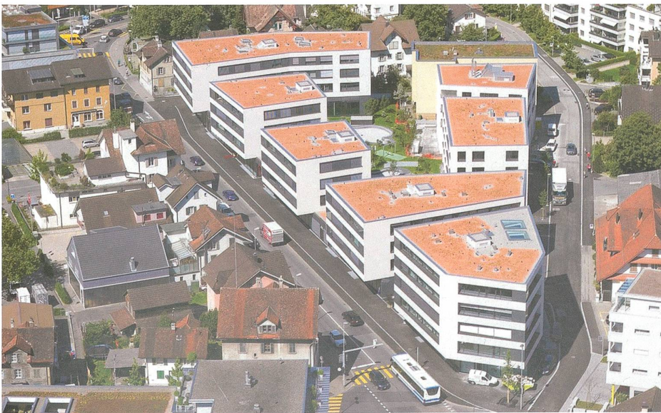
Abb. 1 Verdichtung und Modernisierung im historischen Ortskern. Über- bauung Marktgasse/Falkenweg in Baar, erbaut 2010–2012.
