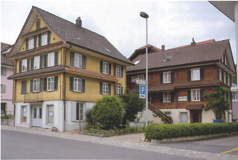
Abb. 35 Unterägeri, Oberdorfstrasse 8 und 10. Die biedermeierlichen Häuser Oberdorfstrasse 10 (links) und Oberdorfstrasse 8 (rechts). Blick nach Nordosten.
