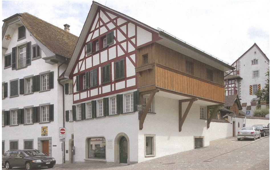
Abb. 49 Zug, St.-Oswalds-Gasse 5a, Pfrundhaus St. Anna. Zustand nach der Renovation 2013. Blick von Südwesten.
