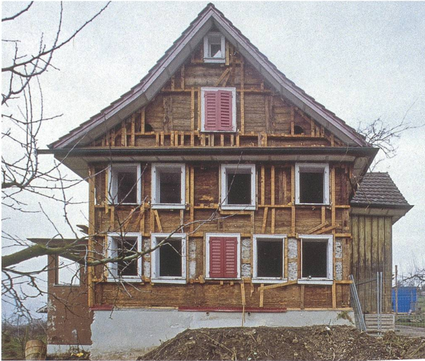
Abb. 44 Zug, Oberwil, Gimenenweg 5, Wohnhaus Bröchli. Südseitige Hauptfassade während der Abbrucharbeiten.
