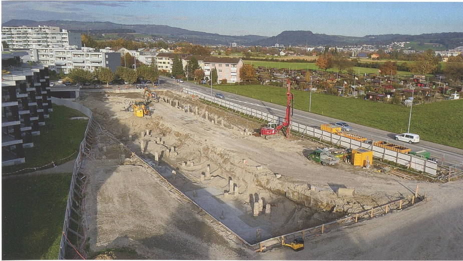
Abb. 46 Zug, Riedmatt, Überbauung Riedpark III. Areal der dritten Riedpark-Bauetappe. Links die bereits bewohnte Überbauung der zweiten Etappe, am Horizont rechts der Mitte die Silhouette der Baarburg. In der bereits teilweise ausgehobenen Baugrube sind die neu erstellten Beton Gründungspfähle der geplanten Gebäude sichtbar.
