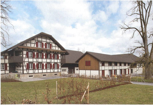
Abb. 26 Cham, Sinslerstrasse, Gutshof Hammer. Ansicht von Süden.
