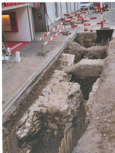
Abb. 54 Zug, Zeughausgasse, Strassensanierung. Im Vordergrund die freigelegte Stadtmauer. Sie war im Fundament gut 2,3 m und im ehemals aufgehenden Bestand knapp 2 m mächtig. Blick nach Norden.
