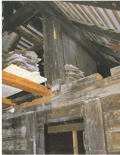
Abb. 41 Zug, Letzi 27, Gast- und Bauernhaus «Zum Freimann». Bauzeitliches Dachwerk. Im unteren Bildbereich ist der von Mantelstützen flankierte Eingang zur Dachkammer erkennbar.
