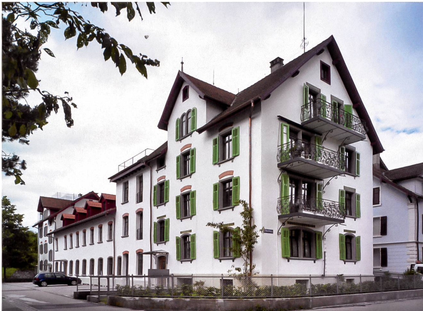
Abb. 1 Zug, Pilatusstrasse 2 und Erlenstrasse 16. Ansicht von Südwesten, nach der Sanierung.
