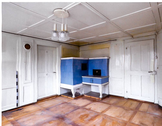
Abb. 33 Unterägeri, Lorzenstrasse 5. Stube mit vollständig erhaltener Raumausstattung von 1856.
