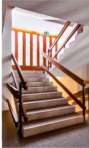
Abb. 4 Treppenanlage mit neuer Fluchttüre auf das Flachdach.
