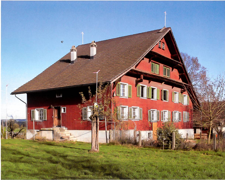
Abb. 1 Cham, Haus Moos. Hauptfassade und Westseite. Blick nach Norden.
