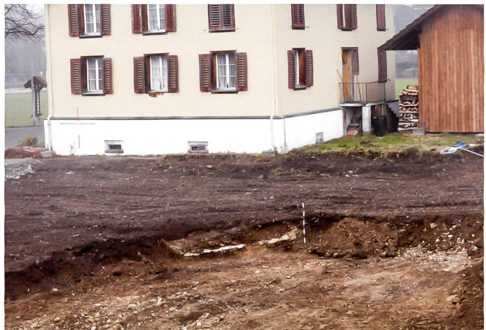
Abb. 7 Baar, Zugerstrasse 29. Wohnhaus der Liegenschaft Feldhof mit angeschnittenem Mörtelmischplatz im Bereich des ehemaligen Gemüsegartens. Situation während des Aushubs der Baugrube für einen Neubau.
