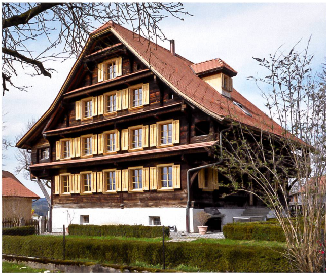
Abb. 1 Risch, Berchtwil 5, Stuberhof. Ansicht von Südosten, nach der Sanierung.
