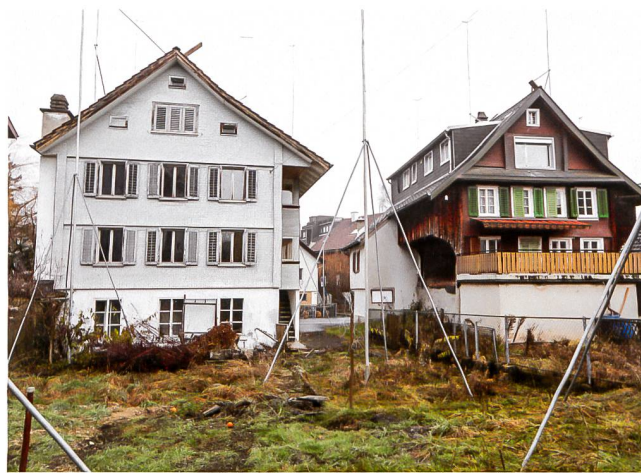
Abb. 32 Unterägeri, Lorzenstrasse 3 (rechts) und 5 (links). Blick nach Norden.
