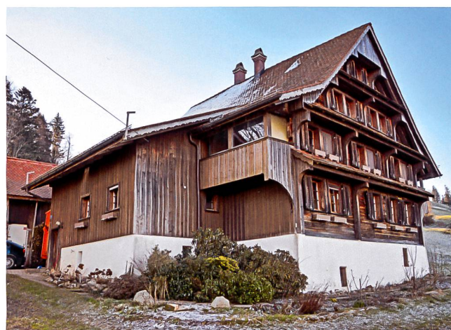
Abb. 47 Zug, Unterhof 1, Wohnhaus. Nord- und Westfassade, vor dem Umbau.
