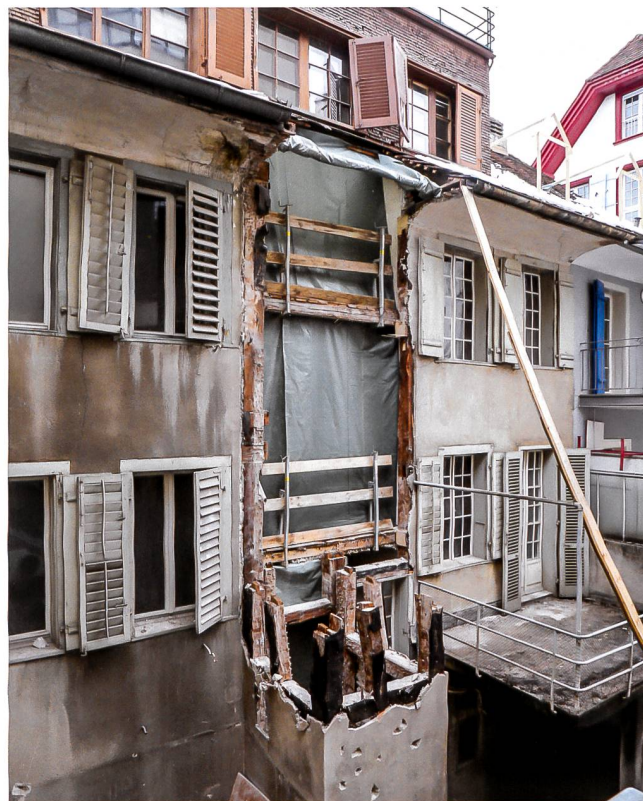
Abb. 35 Zug, Ägeristrasse 4, Wohn- und Geschäftshaus. Für die Verschiebung des Treppenhauses wurde die Südfassade geöffnet und der ehemalige Abort-Standerker abgebrochen.
