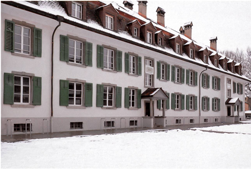
Abb. 1 Cham, Scheuermattstrasse 1–5, «Technikum». Ansicht von Südosten, nach der Sanierung.
