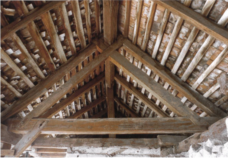
Abb. 3 Blick in die 1642/43 errichtete Dachkonstruktion über dem Wehrgang der Ringmauer.
