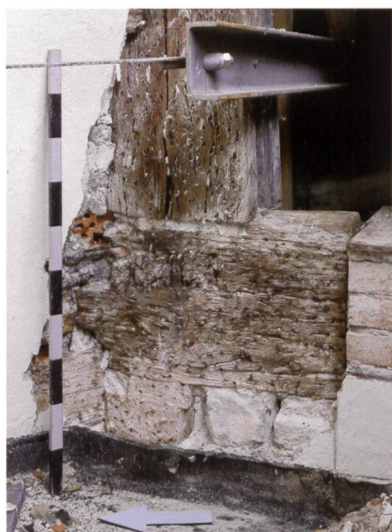
Abb. 36 Zug, Kolinplatz 21. Schwellenverbindung und Ständer an der Nordwestecke des ehemaligen Ständerbohlenbaus. Erkennbar ist der rote Anstrich. Blick nach Osten.
