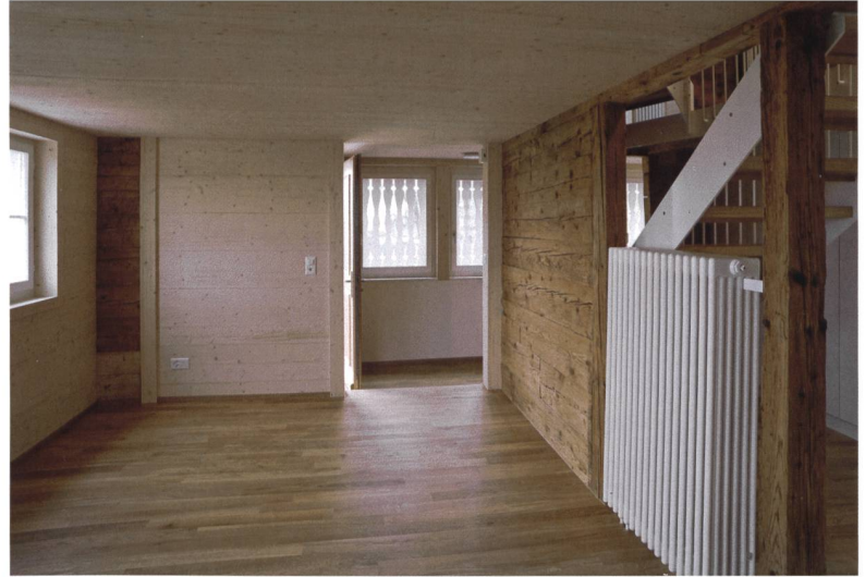
Abb. 4 Innenräume im ersten Obergeschoss, nach der Sanierung.
