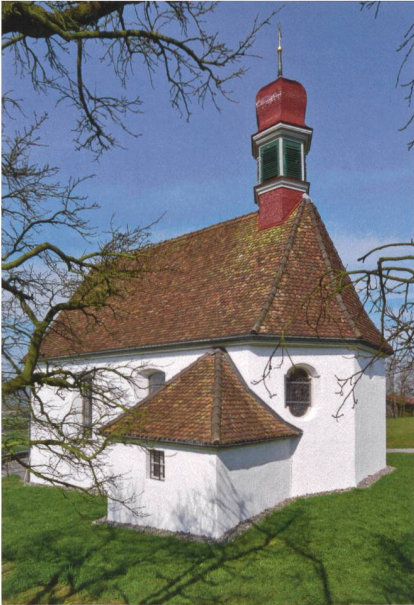
Abb. 22 Hünenberg, Weinreben, Weinrebenkapelle. Ansicht von Südosten.
