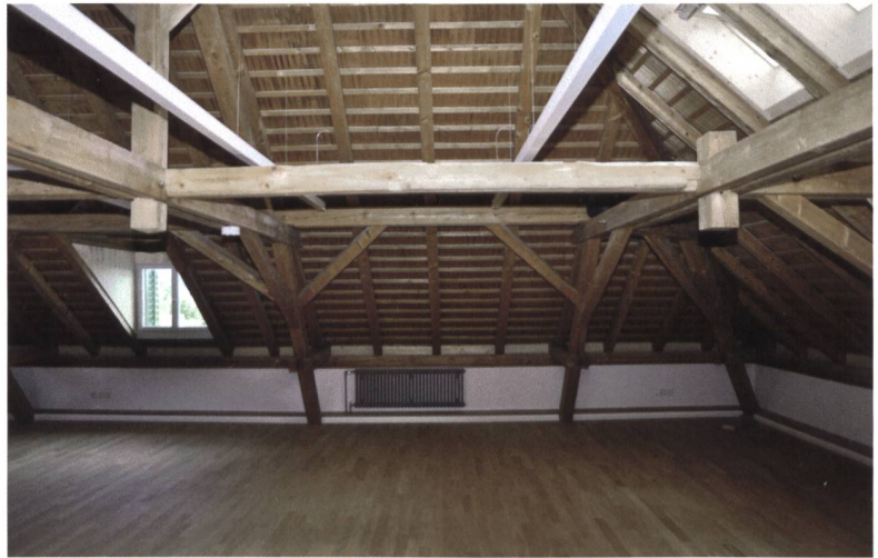
Abb. 4 Dachgeschoss mit originaler Dachkonstruktion und Schindelschirm.
