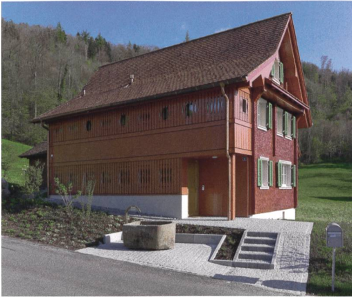
Abb. 3 Ansicht von Nordwesten, mit Laube, nach der Sanierung.
