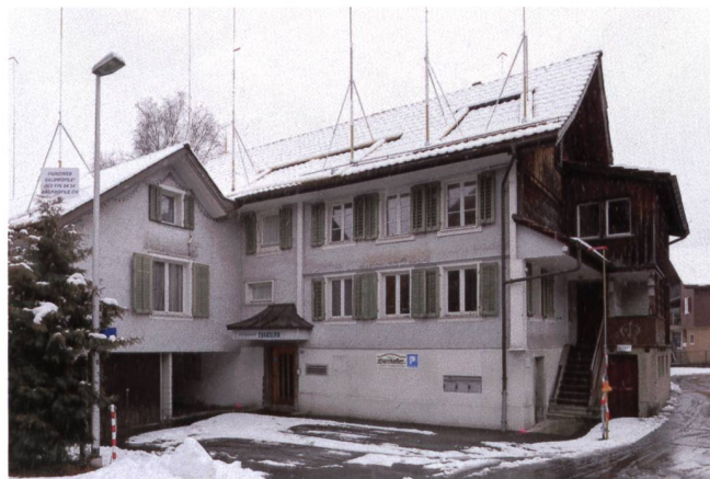
Abb. 30 Unterägeri, Frohsinnweg 3, ehemaliges Restaurant Frohsinn. Ansicht von Nordosten.
