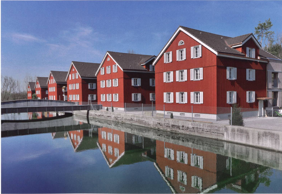
Abb. 16 Cham, Hagendorn, Lorzenweidstrasse 40–54, ehemalige «Kosthäuser». Sechs der insgesamt acht baugleichen Kosthäuser auf der Lorzeninsel.
