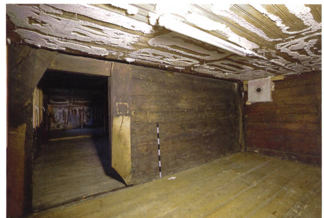
Abb. 20 Hünenberg, Dorfstrasse 2. Reste der Bohlenständerkonstruktion aus der Zeit um 1472/73. Die Türöffnung mit Mantelständer stammt aus einem späteren Umbau.
