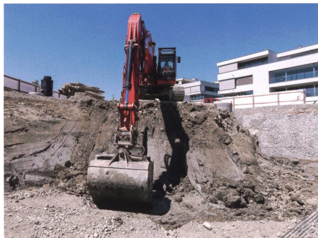
Abb. 12 Cham, Eichmatt II. Stratigrafie in der Böschung im Westen der Baugrube, nahe der Eichmattstrasse auf Höhe der Sportanlage Kemmatten. Die im Osten der Fläche gefassten See- und Verlandungssedimente fehlen hier vollständig.
