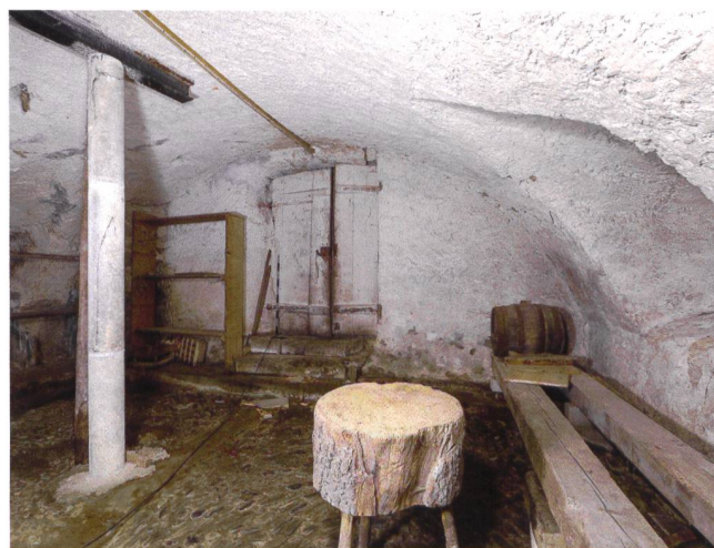
Abb. 9 Baar, Talacher 3. Tonnengewölbter Keller im hangseitigen Teil des Sockelgeschosses. Blick nach Westen.
