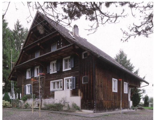
Abb. 4 Baar, Burgmatt 17. Freiliegende Ständerkonstruktion der Ostfassade und einstige Laube an der nördlichen Trauffassade.
