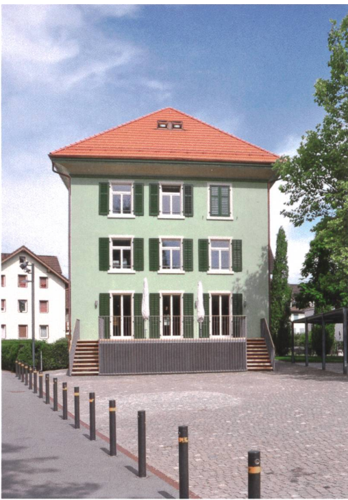
Abb. 1 Baar, Leihgasse 9, «Schwesternhaus». Ansicht von Westen, mit neuem Terrassenanbau.
