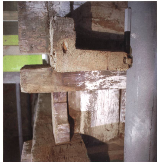
Abb. 2 Ungewöhnlicher «Winkelbalken» bei der Ostfassade, dient zugleich als Schwelle für den Blockbau als auch als östlichste Bodenbohle.
