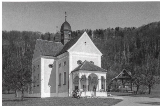
Abb. 2 Kapelle St. Verena. Rechts im Hintergrund das Bruderhaus, Ansicht von Westen, 1996.
