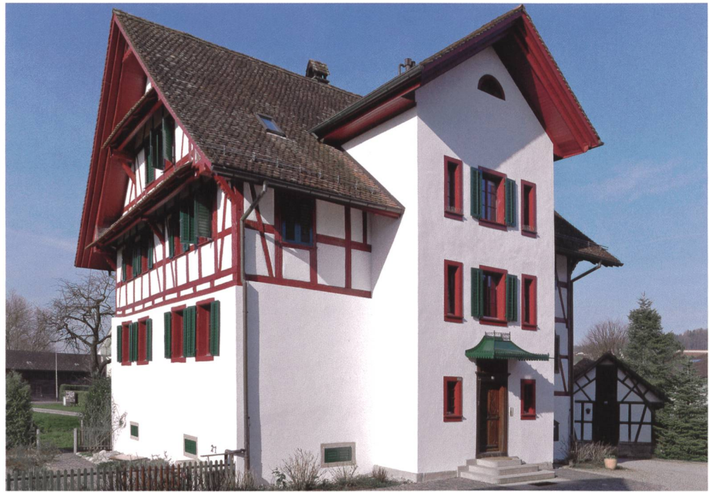
Abb. 6 Baar, Neugasse 40. Wohnhaus. Ansicht von Südosten.
