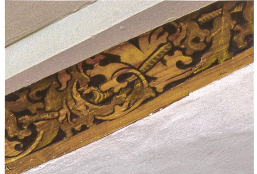
Abb. 2 Untere Münz. Stube im zweiten Obergeschoss. Freigelegter Balken mit flachem, floralem Schnitzwerk.
