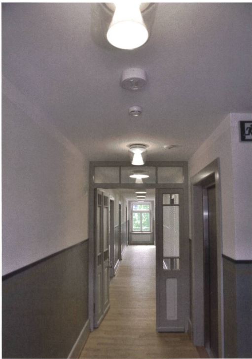
Abb. 3 Korridorzone im zweiten Obergeschoss, mit neuem Brandabschluss.
