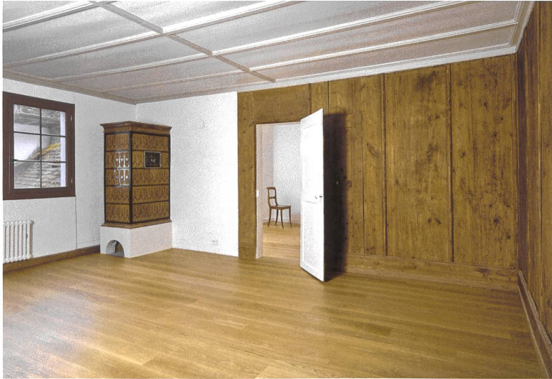
Abb. 3 Untere Münz. Schlafzimmer im zweiten Obergeschoss des Hinterhauses, mit holzsichtigem Wandtäfer und Brettertäferdecke, nach der Restaurierung.
