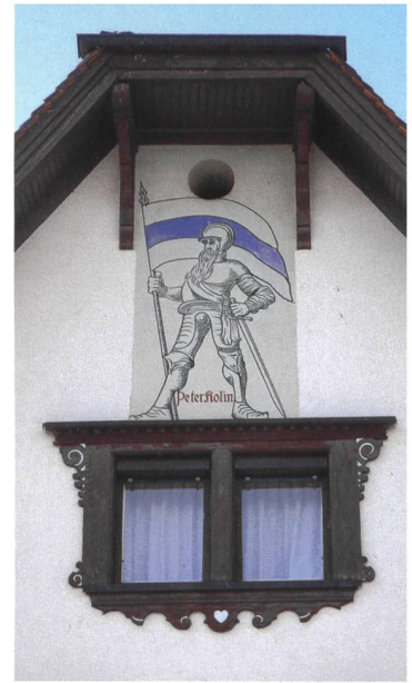
Abb. 4 Ostfassade, Giebel mit Darstellung des Zuger Fähnrichs Peter Kolin, Zustand 2015.
