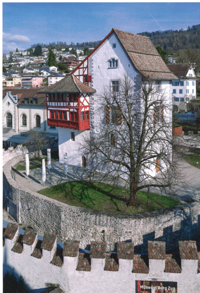
Abb. 35 Zug, Kirchenstrasse 11, Burg Zug. Ansicht von Südwesten, nach der Sanierung.
