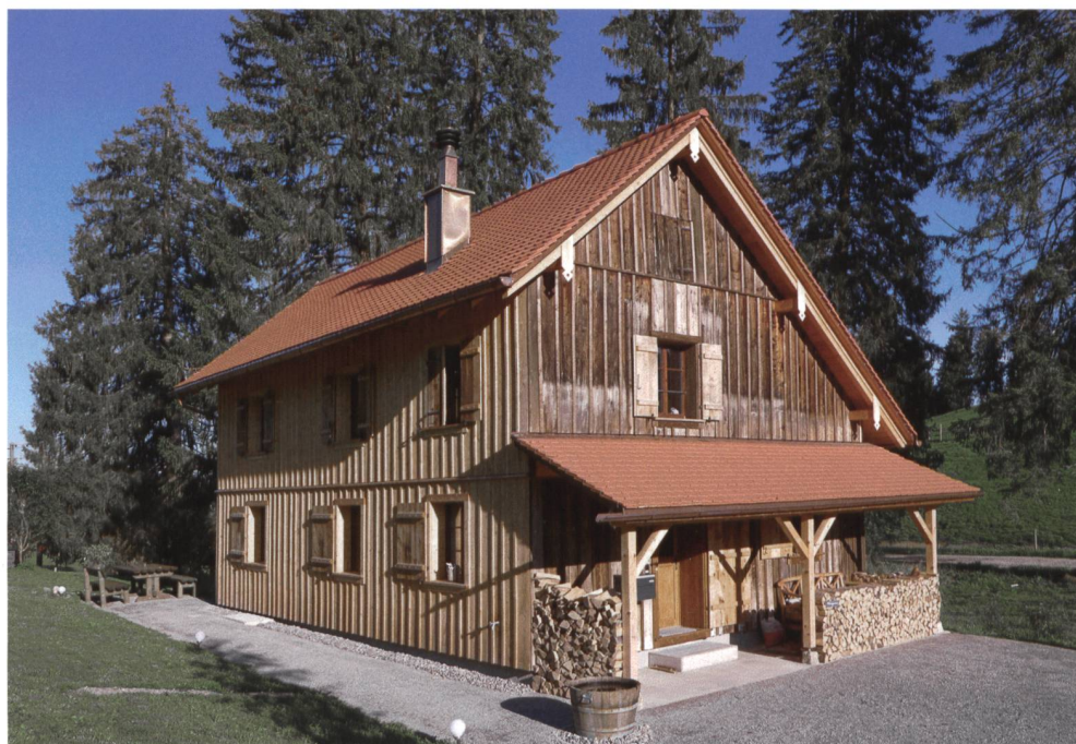
Abb. 34 Zug, Hintergeissboden 1–2, «Gaumerhaus». Ansicht von Südosten, nach der Sanierung.
