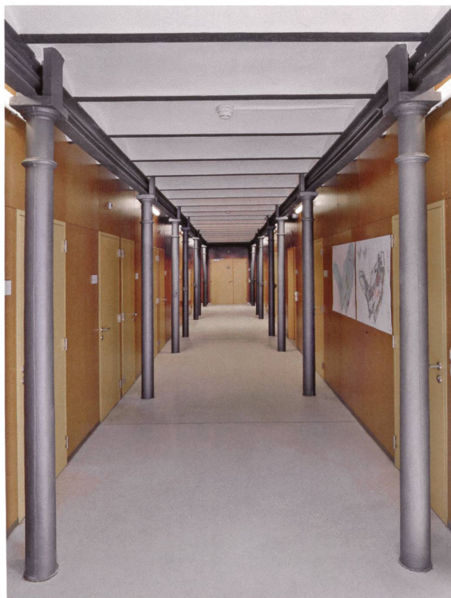
Abb. 25 Risch, Buonas, ehemalige Stallscheune. Innenansicht nach dem Umbau mit der Konstruktion von Hourdisdecken auf kunstvollen Gusseisensäulen.
