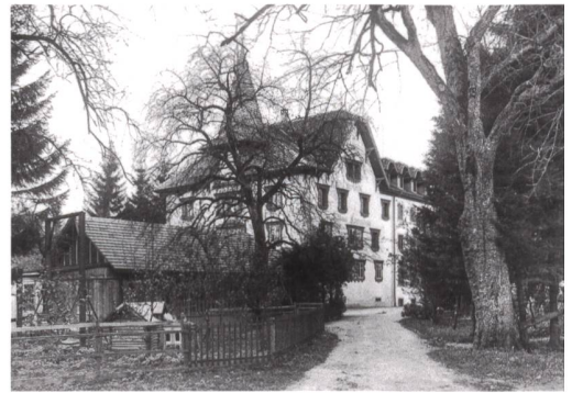
Abb. 2 Ansicht von Südosten, um 1900.
