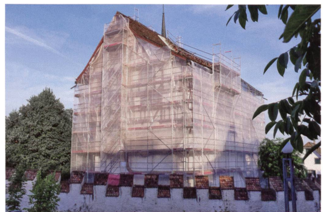
Abb. 6 Die verhüllte Burg während der Fassadensanierung.
