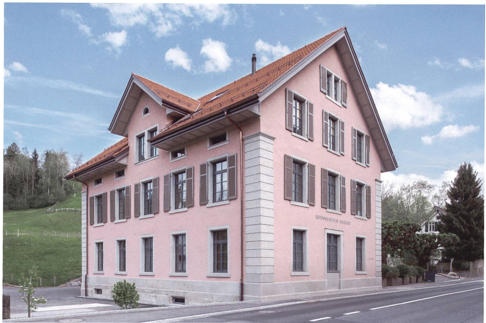
Abb. 14 Menzingen, Zugerstrasse 186. Das ehemalige Kontorhaus wurde 1868 erbaut und ist wichtiger Teil des baulichen Ensembles «Spinnerei Neuägeri», welches industriegeschichtlich bedeutend und ortsbildprägend ist. Ansicht von Südwesten.
