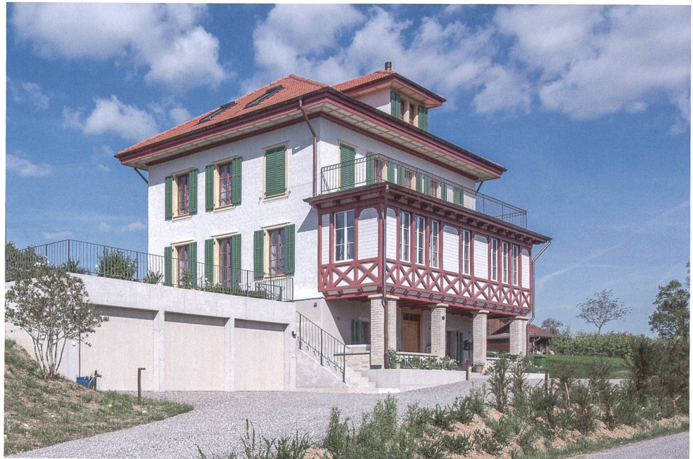
Abb. 10 Hünenberg, Huobweid, Kemberghof. Wohnhaus mit Veranda auf der Ostseite. Heutiger Zustand, Ansicht von Südosten.
