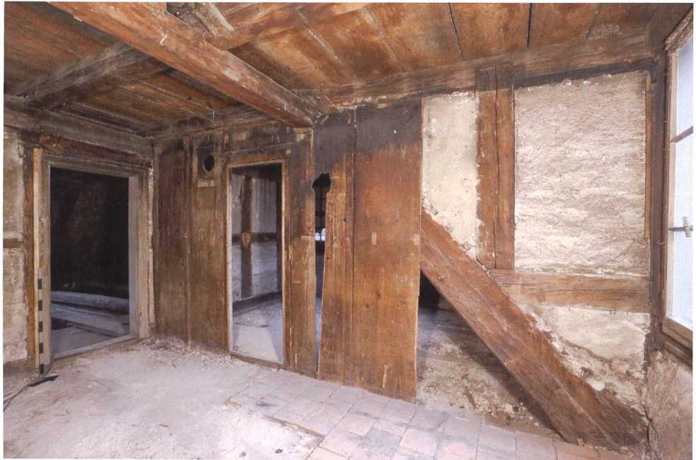
Abb. 36 Zug, Kolinplatz 19. Dachgeschoss. Mittleres Joch des liegenden Dachstuhls mit zur Dachlukarne verlängertem Kehlbalken. Blick nach Norden.
