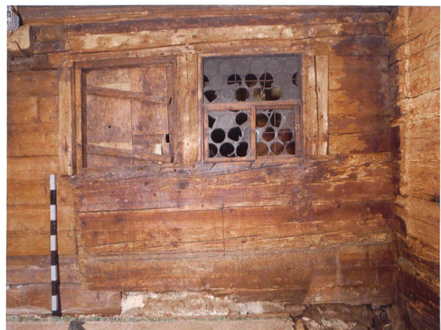
Abb. 13 Menzingen, Alte Landstrasse 8. Stubenwand mit bauzeitlichem Doppelfenster. Blick nach Nordosten.
