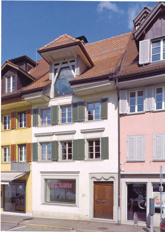
Abb. 41 Zug, Vorstadt 14. Das Wohn- und Geschäftshaus zählt zu den ältesten Bauten der Vorstadt-Häuserzeile. Es ist eines von sieben Gebäuden, die aus der Zeit vor der sogenannten Vorstadtkatastrophe (Uferabbruch) von 1887 stammen. Ansicht von Südwesten.
