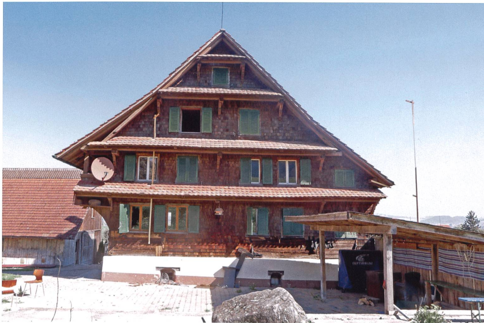
Abb. 18 Risch, Obere Bach-talen 2. Rückwärtige Giebel-fassade in Kantholzständer-bauweise.
