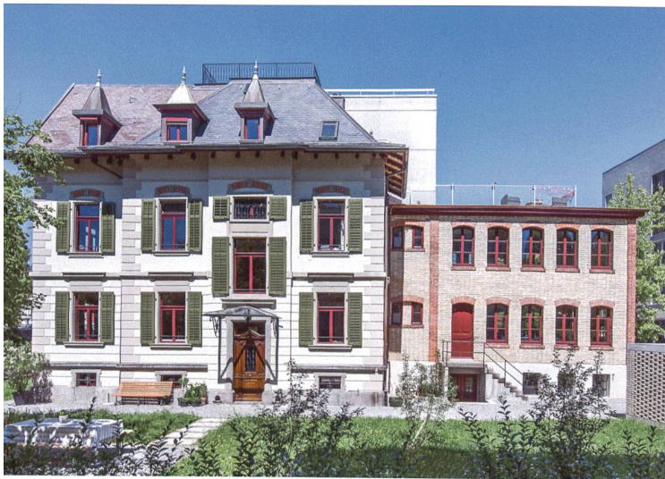
Abb. 1 Zug, Chamerstrasse 10, Villa Staub mit «Fabrikli». Ansicht von Osten, nach der Restaurierung.
