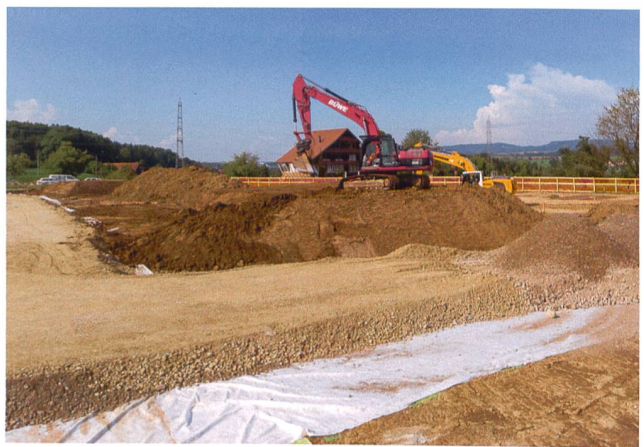
Abb. 6 Cham, Mugerenstrasse 29–39 und 70–82. Situation bei der Erstbegehung der Baustelle, Blick gegen Nordnordost, links hinter dem Bagger das 2015 umgebaute Bauernhaus der Hofgruppe Moos. Im Süden der Parzelle ist der Humus bereits weitgehend abgetragen. Die ersten Scherbenfunde stammen aus dem Bereich der Baupiste im Vordergrund.
