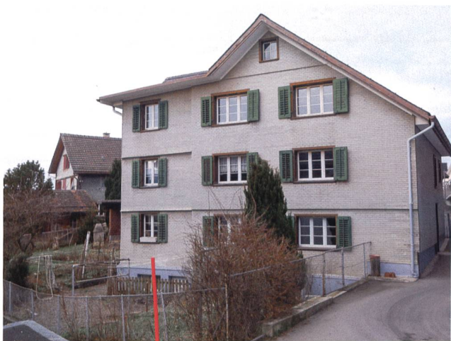
Abb. 12 Menzingen, Alte Landstrasse 8. Ansicht von Osten, im Hintergrund das Haus Eustrasse 1.
