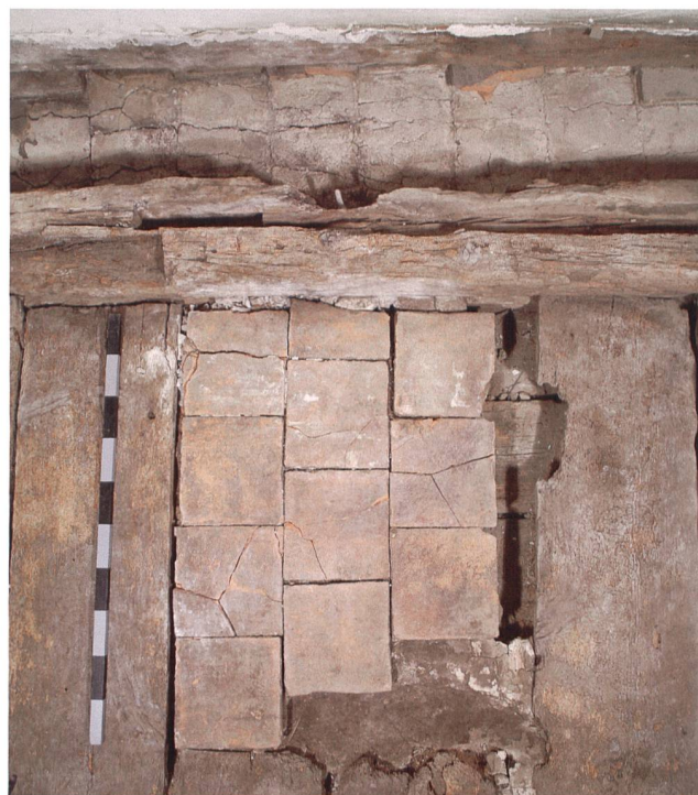
Abb. 7 Zug, Unteraltstadt 26, erstes Obergeschoss, Boden von 1462d, Aufsicht. Fundament eines Kachelofens. Blick nach Westen.
