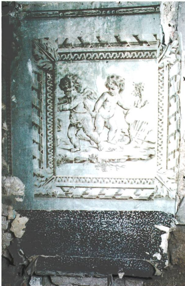
Abb. 12 Zug, Ägeristrasse 9, Vorderhaus, zweites Obergeschoss, Raum 3.2/3.3. Lambris- und Sockeltapeten. Die Tapeten wurden lediglich fotografisch dokumentiert und konnten nicht genau bestimmt werden. Vermutlich handelt es sich um Handdrucke auf Bogenrollen, um 1780/90.
