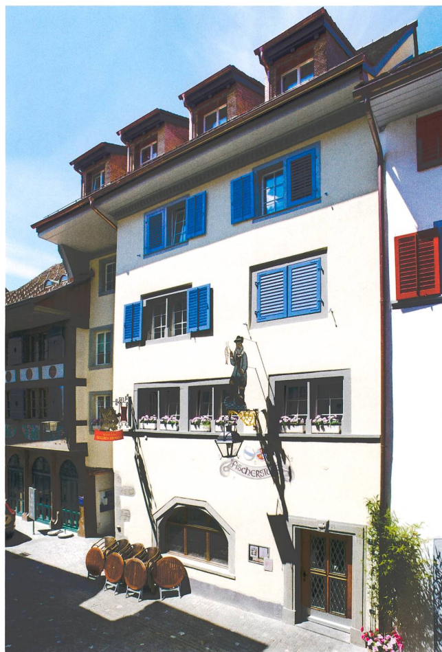
Abb. 1 Zug, Unteraltstadt 12 («Fischerstube»). Gassenfassade, Zustand 2013. Blick nach Südwesten.
