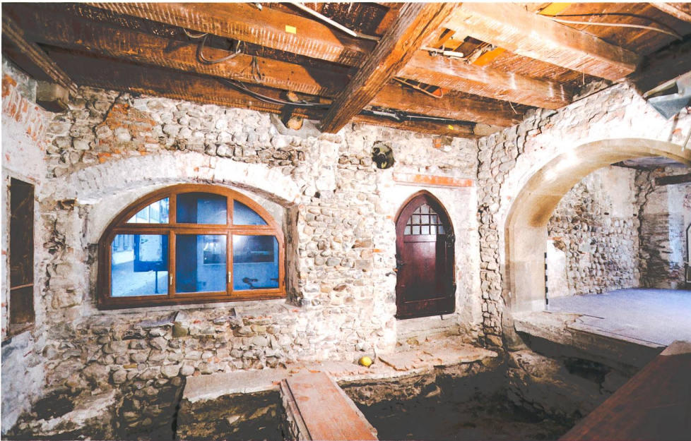
Abb. 26 Zug, Unteraltstadt 12. Gassenseitiger Raum der Erdgeschosshalle. Rechts ist der raumtrennende Bogen sichtbar. Blick nach Südwesten.
