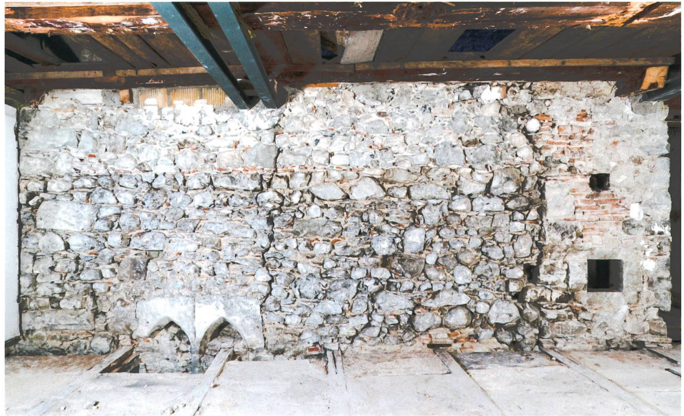
Abb. 20 Zug, Unteraltstadt 12, zweites Obergeschoss. Süd-mauer, Blick nach Norden.
