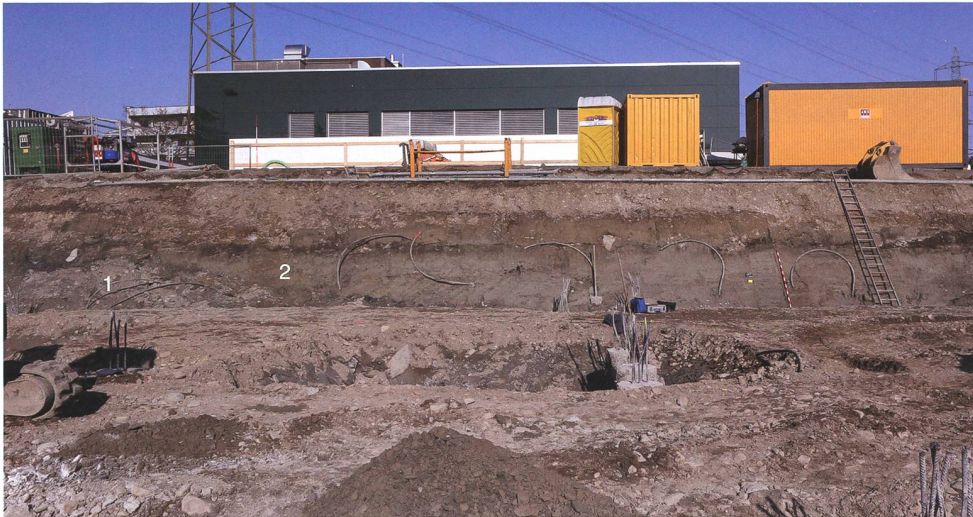
Abb. 12 Steinhausen, Zugerstrasse 50. Nordostprofil. 1 Geschiebemergel der Moräne. 2 Gegen links auskeilende Seesedimente aus fein geschichtetem schluffigem Ton und Feinsand, Oberkante auf rund 418 m ü. M. Sie zeigen einen wohl spätglazial-frühholozänen Flachwasserbereich oder Seerand an.
