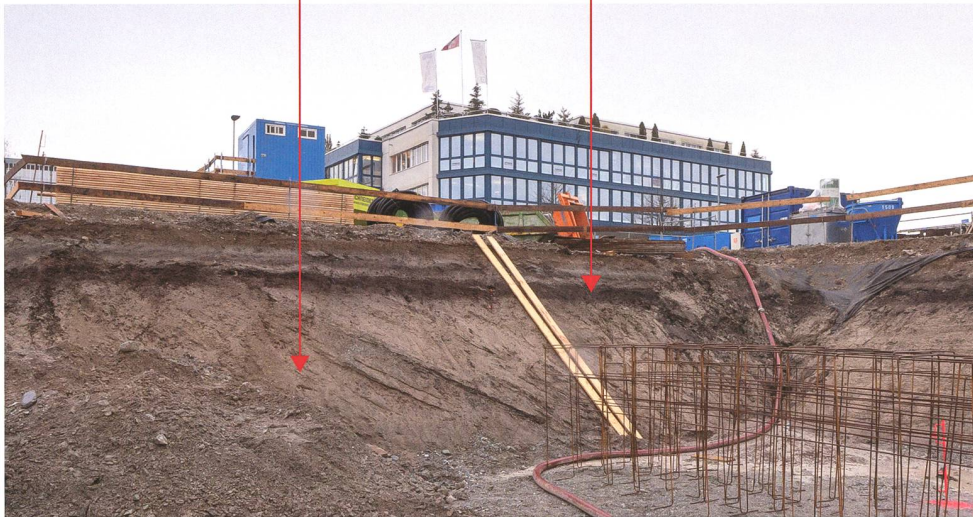
Abb. 14 Steinhausen, Sumpfstrasse 18. Südsüdwest-Profil. In der Baugrubenböschung sind die mehrere Meter mächtigen, gegen Südwesten einfallenden foreset beds aus fein geschichteten grauen Sanden mit dünnen Straten aus botanischen Makroresten zu erkennen, die noch aus dem Ende der Späteiszeit stammen. Die darüberliegenden torfigen Sedimente wurden erst in der Frühbronzezeit gebildet (s. auch Abb. 28).
