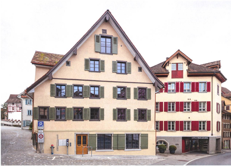
Abb. 1 Zug, Ägeristrasse 20. Strassenfassade nach der Sanierung 2020.
