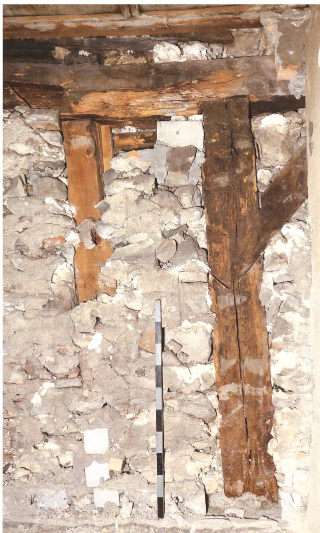
Abb. 24 Zug, Grabenstrasse 32. Ständer und Deckenbalken des hölzernen Erdgeschosses von 1371 in der südlichen Brandwand. Ansicht vom Haus Grabenstrasse 34, Blick nach Nordosten.
