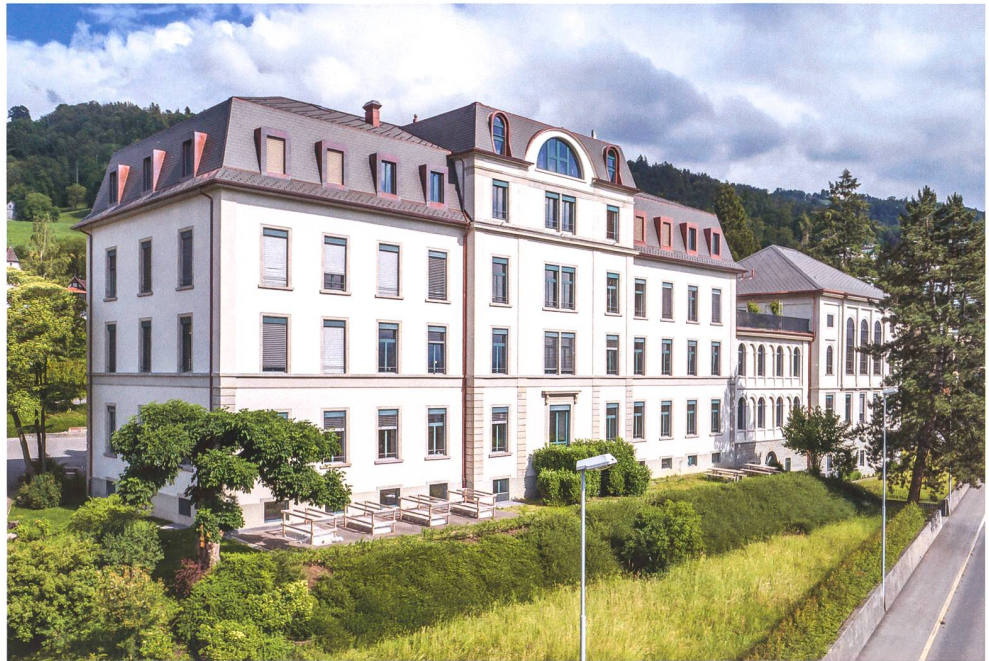
Abb. 34 Zug, Zugerbergstrasse 3, Kollegium St. Michael. Hauptgebäude, Zwischentrakt und Kapelle des Kollegiums St. Michael nach der Sanierung. Ansicht von Nordwesten.
