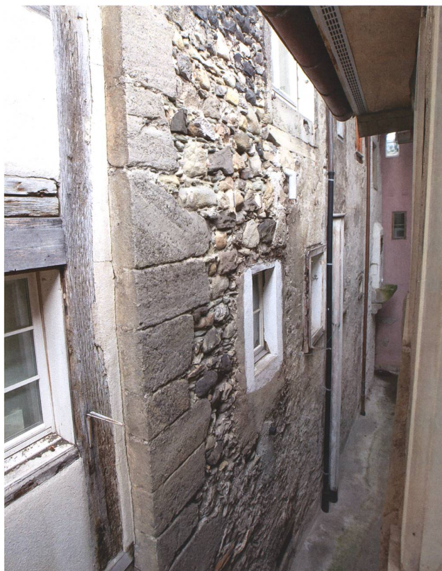
Abb. 30 Zug, Oberaltstadt 16. Ehgrabenseitige Hauswand mit sauberem Eckverband. Blick nach Süden.
