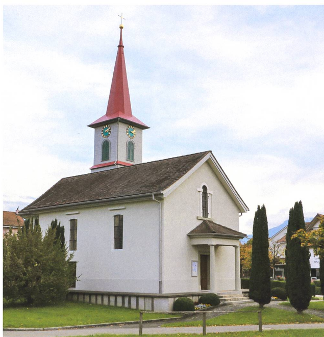
Abb. 12 Risch, Holzhäuserstrasse, Kapelle St. Wendelin. Ansicht von Nordwesten.
