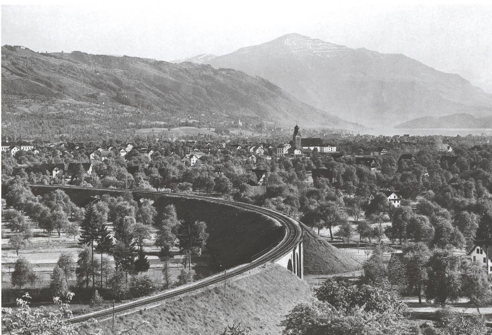
Abb. 3 Bis weit ins 20. Jahrhundert hinein prägten die Kirchtürme die Siedlungslandschaft. Baar, Ansicht von Norden, um 1910.
