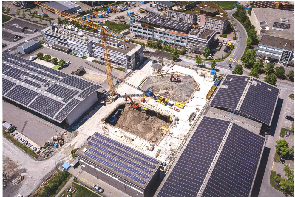
Abb. 18 Zug, Chollerstrasse 26. Bauperimeter kurz nach Aushubbeginn. Die Deckelplatte der Untergeschosse weist zwei grosse Öffnungen für die Aushubagger auf. Blick nach Nordwesten in Richtung Autobahn. Oben rechts noch knapp angeschnitten das Gebäude Erlenweg 5 im Rohbau; die Sumpfstrasse 18 befindet sich rund 100 m weiter links. Der Aufnahmestandort des Bildes befindet sich fast direkt über dem Lauf der Alten Lorze.
