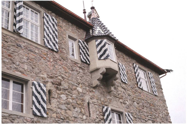
Abb. 4 Neu verputzter Erker an der Nordostfassade. Blick nach Westen.
