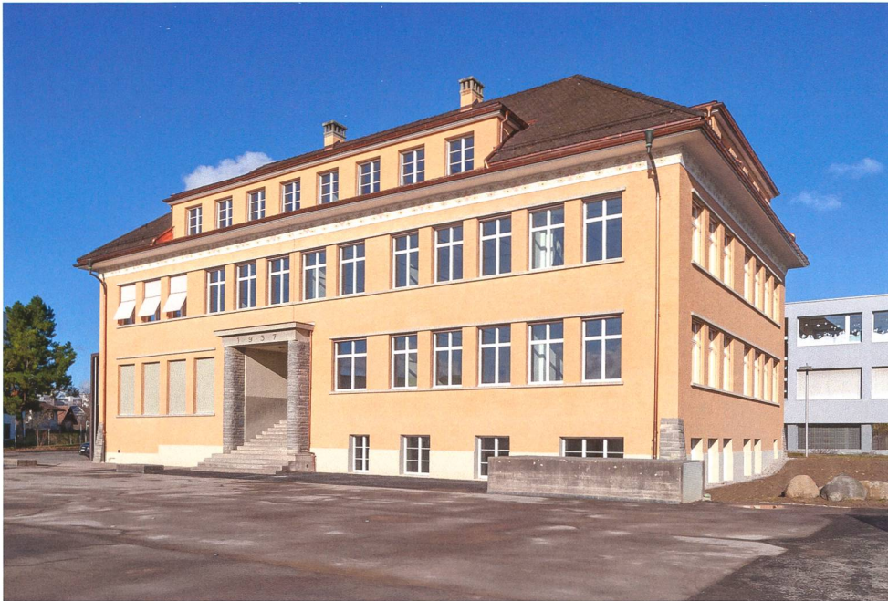
Abb. 14 Steinhausen, Blickendorferstrasse 15, Musikschulhaus Sunnegrund I. Das restaurierte, neu zur Musikschule umgenutzte Schulhaus. Ansicht von Südosten.
