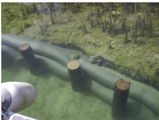
Abb. 9 Seit 1997 ergreift der Kanton Zug bauliche Massnahmen zum Schutz der Schilfpflanzen und von archäologischen Fundschichten im untiefen Wasser. Mittels Holzpfählen wird die Kliffkante der Flachwasserzone stabilisiert, um die Erosion zu stoppen.
