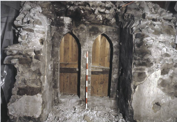
Zug, Unteraltstadt 28. Bei der Bauuntersuchung von 1980 zum Vorschein gekommenes gekuppeltes Bogenfenster (Biforie). Die Russpuren auf dem Sandstein der Biforie und auf dem umgebenden Mauerwerk sind auch Jahrhunderte nach dem Brandereignis noch deutlich sichtbar.
