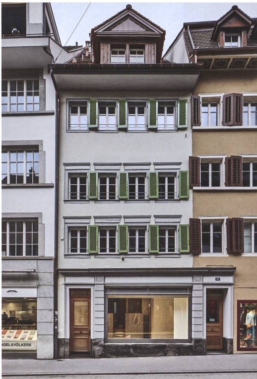
Abb. 1 Zug, Neugasse 17. Blick auf die sanft restaurierte Westfassade. Gut sichtbar ist das Sockelgeschoss, welches über die Parzelle hinaus ins Nachbargrundstück reicht.
