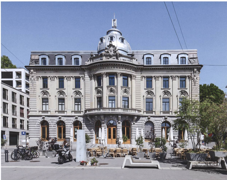
Abb. 1 Zug, Postplatz 1, Postgebäude. Ehemaliges, stattliches Postgebäude mit renovierter Natursteinfassade und neuem Schieferdach, Ansicht von Westen.
