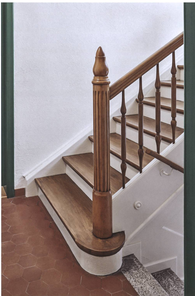
Abb. 23 Zug, Aabachstrasse 15/17 und Hertistrasse 6/8, Treppenhäuser. Die Treppenhäuser der Mehrfamilienhäuser (hier Haus Hertistrasse 6/8) wurden sorgfältig restauriert und in ihrer bauzeitlichen Farbigkeit nach Befund wiederhergestellt.
