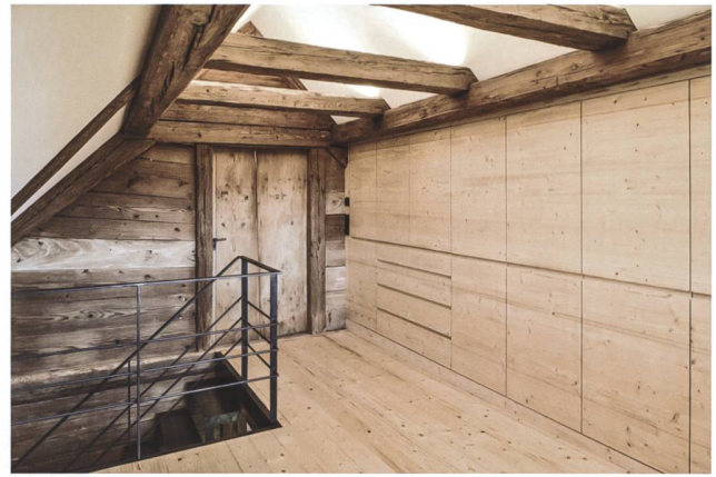
Abb. 4 Dachgeschoss mit Blockwand und historischer Türe und teilweise sichtbarem Dachstock.
