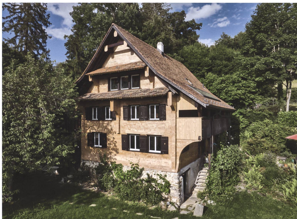
Abb. 26 Zug, Brüschrain 26, Haus Potthoff. In der Gesamtansicht von Westen kommen die neuen Lärchenschindeln gut zur Geltung.
