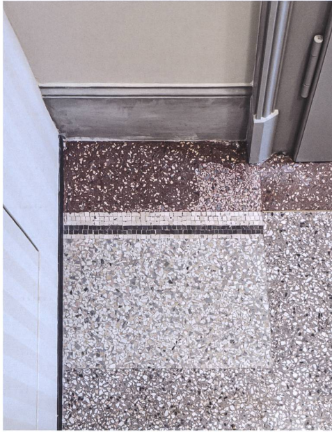
Abb. 3 Ausschnitt aus dem neuen Terrazzoboden im Erdgeschoss mit integriertem historischem Terrazzo-Reststück.
