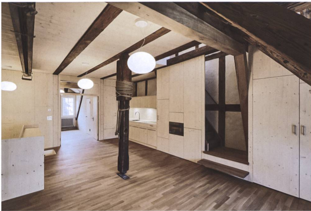
Abb. 3 Einblick in die grosszügige Dachwohnung im ehemaligen Estrich des Hauses. Historisches Dachwerk, Fachwerkwand, Estrichtreppe und Lastenaufzug mit Winde bleiben erhalten.
