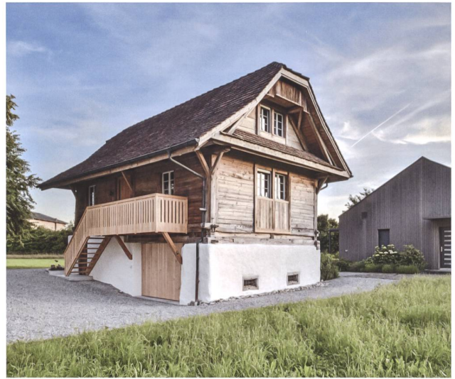
Abb. 2 Ansicht von Nordosten mit Schiebeläden und erneuerter Treppe.
