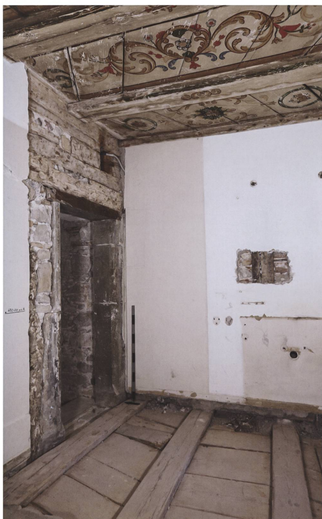
Abb. 33 Zug, Kolinplatz 1. Korridor mit Deckenmalereien im zweiten Obergeschoss während der Bauuntersuchung.
