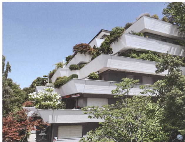
Abb. 2 Zug, Terrassenweg 1–9 und Rothusweg 1–11a, Terrassenhäuser. 1958–1961 erbaut von Fritz Stucky und Rudolf Meuli, Zug. Die Terrassenhäuser sind als erste ihrer Art in der Schweiz von grosser architekturgeschichtlicher Bedeutung.
