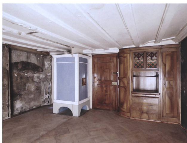
Abb. 25 Zug, Ägeristrasse 3. Blick in die Stube im ersten Obergeschoss mit Bohlenbalkendecke und dem Überrest der (Bett-)Nische aus dem 16. Jahrhundert. In der Nische ist der Abdruck der seitlichen Ofentreppe eines Kachelofens des 17. Jahrhunderts zu sehen. Der hellblaue Kachelofen, das Tafelparkett, die Türe und das Buffet stammen aus dem 19. Jahrhundert.
