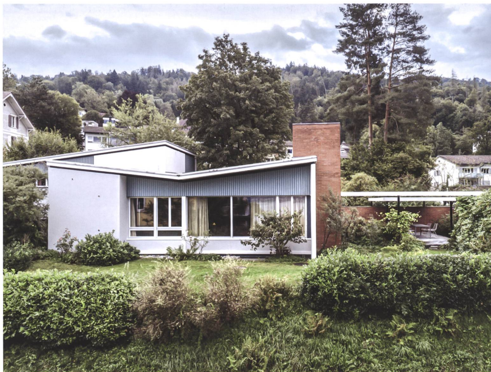
Abb. 28 Zug, Guggitalring 8. Aussenansicht von Westen nach der Sanierung.
