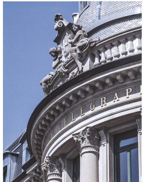
Abb. 2 Sorgfältig restaurierte, auf der Bahnstrasse des Mittelrisalits sitzende Figurengruppe mit Kartusche aus Sandstein.
