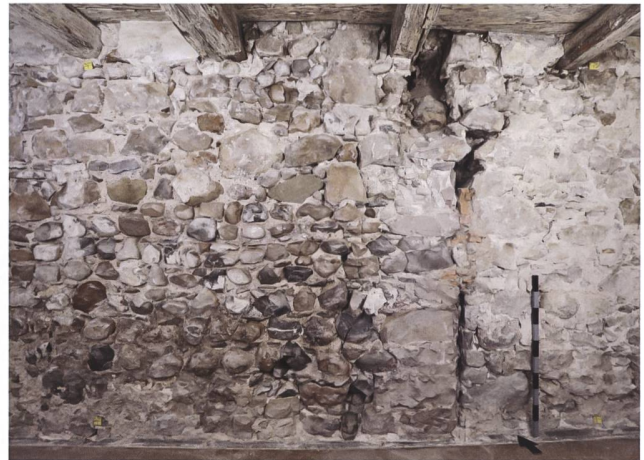
Abb. 4 An der westlichen Nordwand im 1. Obergeschoss sind links ein älterer, durch Brand geröteter Mauerabschnitt und die sekundär eingebauten Deckenbalken von 1512d zu sehen.
