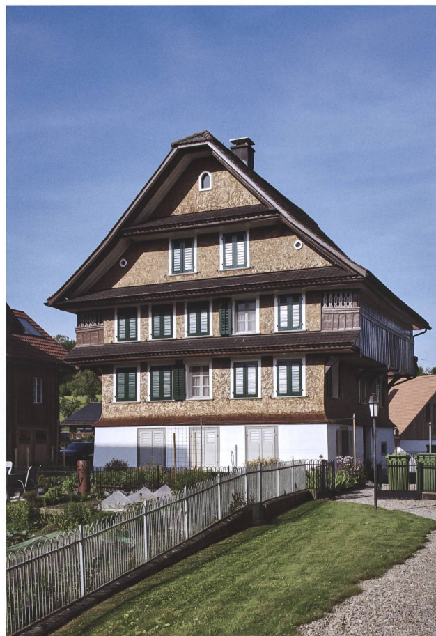
Abb. 11 Cham, Niederwil, Kaplanenhaus. Das Kaplanenhaus erhielt anlässlich der Fassadensanierung eine neue Farbigkeit und strahlt wieder mit den umliegenden Baudenkmalern um die Wette.
