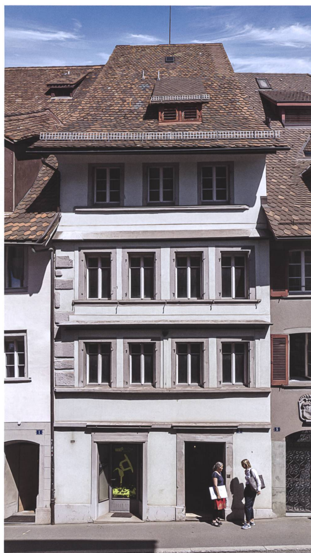
Abb. 24 Zug, Ägeristrasse 3. Südsansicht mit den Nachbarhäusern Ägeristrasse 1 (Linde, links) und Ägeristrasse 5 (rechts).
