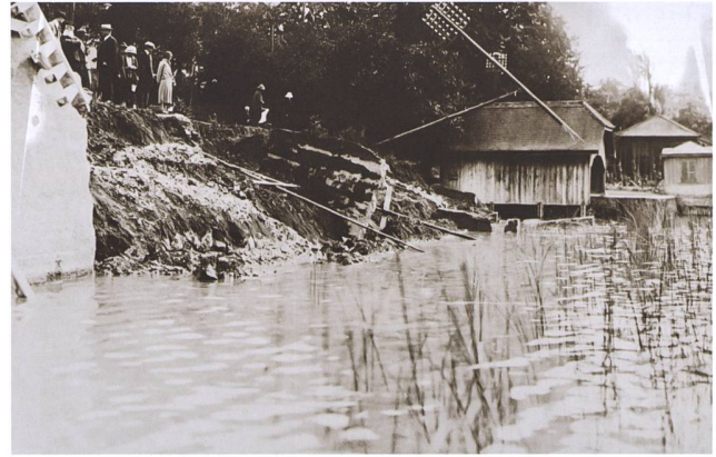
Abb. 7 Überschwemmungen und Erdschlipfe führten immer wieder zu Sachschäden. Ende Juli 1874 versank infolge des Dauerregens beispielsweise ein 120 Fuss langes Stück der Strasse von Zug nach Arth im Zugersee. Passanten bestaunen den Einsturz der Ufermauer bei der Zug-Arth-Strasse in Zug. Fotografie, 1925.
