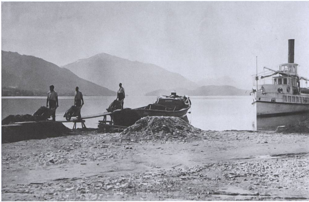
Abb. 6 Das benötigte Kies für den Strassenbau musste zur Baustelle transportiert werden. Im Bild ist der Antransport von Kies und Sand mit dem Ledischiff Delphin in Zug zu sehen. Teilweise kam es auch zu Kies-Absteigerungen: Dabei wurde es dem Mindestfordernden überlassen, das «Grien» innert einer gewissen Frist in bestimmten Quantitäten auf angegebenen Strassenstrecken abzuladen. Fotografie, um 1900.
