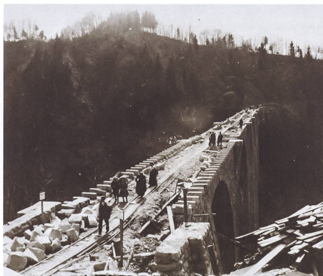
Abb. 10 Blick auf die Baustelle der 186,5 Meter langen, steinernen Lorzentobelbrücke bei Menzingen, die mit ihren Massen im Vergleich zu den im 19. Jahrhundert realisierten Brückenbauten in neue Dimensionen vorstieß. Fotografie, um 1908.
