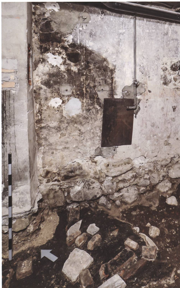
Abb. 6 Zug, Grabenstrasse 34. Ansicht an die Vormauerung (15) mit dem schwarzen Abdruck eines Brennraumes.
