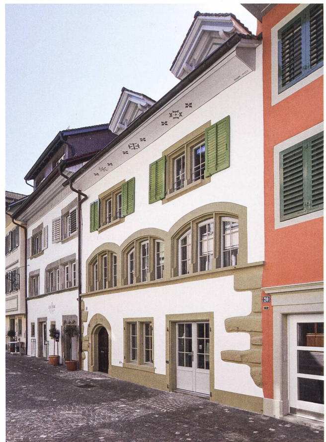
Abb. 48 Zug, Unteraltstadt 22. Gassenseitige Fassade. Das Schönbrunnerhaus, das in wesentlichen Teilen noch aus dem Jahr 1521 stammt, wurde innen und aussen umfassend saniert.
