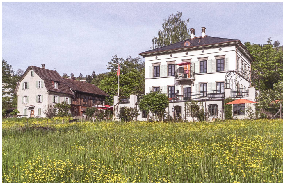
Abb. 1 Zug, Kirchmattstrasse 1. Die repräsentative Villa Marchand erstrahlt nach einer sorgfältigen Fassadensanierung in neuem Glanz.
