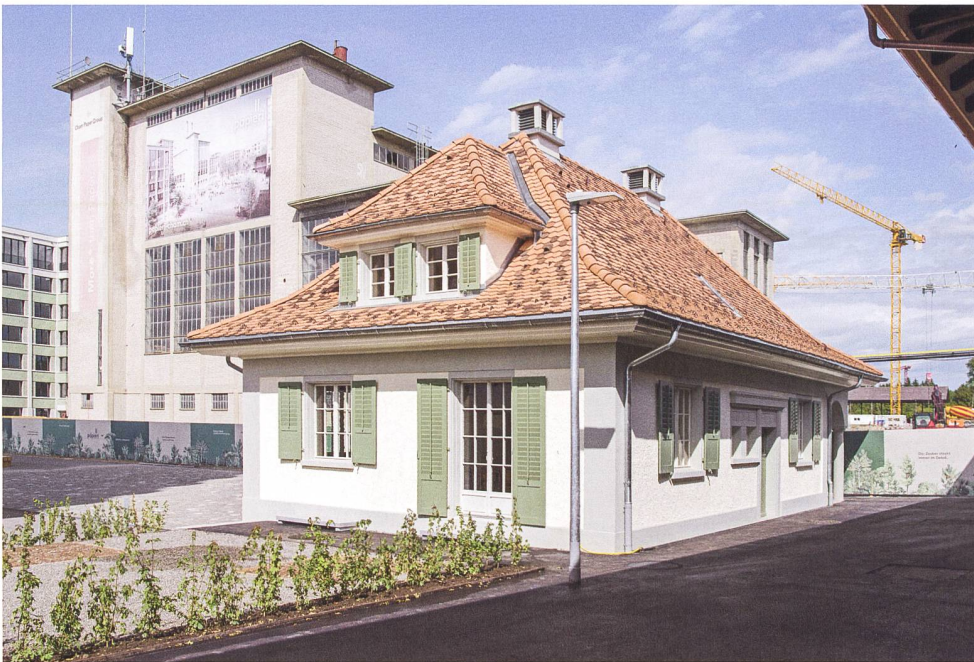
Abb. 21 Cham, Papieriplatz 2, Papieri-Areal. Portierhaus. Ansicht von Südosten. Einst Ankunftsorort für Angestellte und Gäste, beherbergt der schicke Kleinbau heute einen Gemeinschaftsraum für das Quartier.
