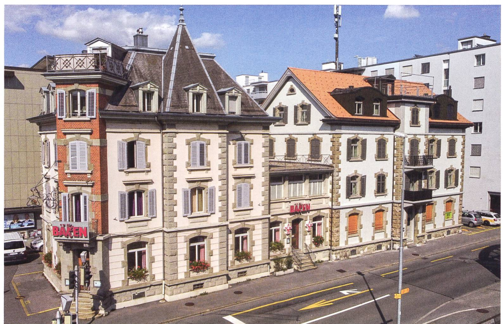
Abb. 41 Zug, Metallstrasse 1. Aussenansicht von Südwesten. Das Wohn- und Geschäftshaus Metallstrasse 1 (rechts im Bild) wurde zusammen mit dem Gasthaus Bären kurz vor 1900 errichtet. Die jüngst abgeschlossene Aussensanierung lässt sein reichhaltiges Fassadendekor aus der Blütezeit des Historismus wieder voll zur Geltung kommen.
