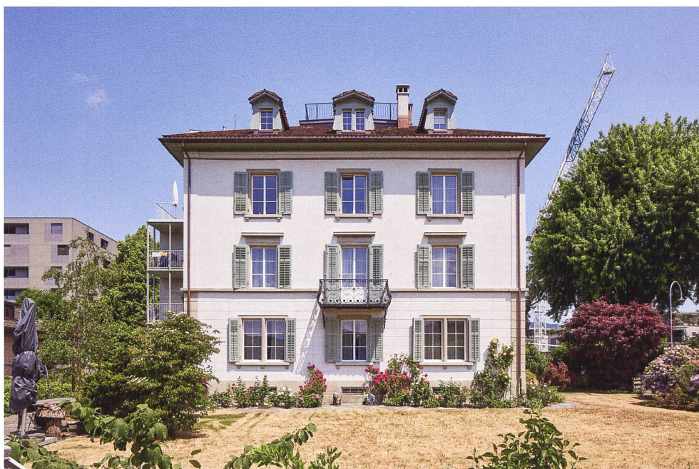
Abb. 4 Baar, Obermühle 1. Ansicht von Süden. Das herrschaftliche Wohnhaus von 1872/73, in dem auch die Büroräume des Mühlebetriebs untergebracht waren, wurde um einen sorgfältig gestalteten Anbau ergänzt. So kann die neue obere Wohnung erschlossen werden, ohne wertvolle innere Substanz zerstören zu müssen.
