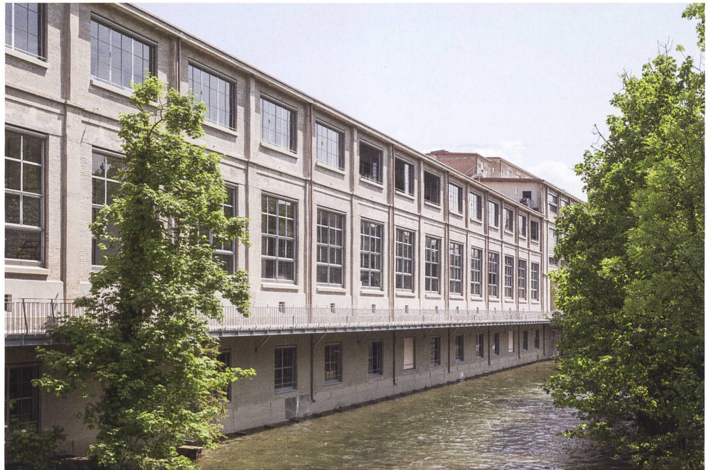
Abb. 20 Cham, Maschinen-gasse, Papiermaschinenhallen PM1–2, PM3–4 und Holländer-gebäude. Ansicht von Nord-westen. Die Aussenräume für die Wohnungen wurden auf der Flussseite als durchlaufende Loggia in das Gebäudevolumen integriert. Dies ermöglichte, das Fassadenbild möglichst intakt zu erhalten.
