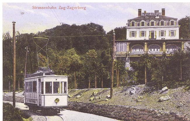
Abb. 18 Die neue Strassenbahn der ZBB bei der Pension Waldheim, 1908.
