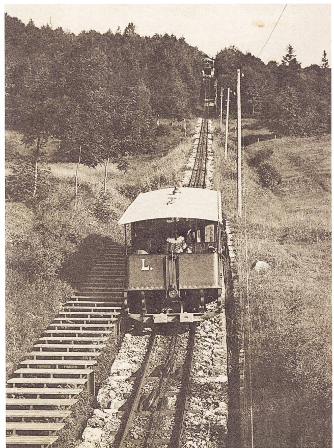
Abb. 19 Die 1907 eröffnete Standseilbahn auf den Zugerberg.
