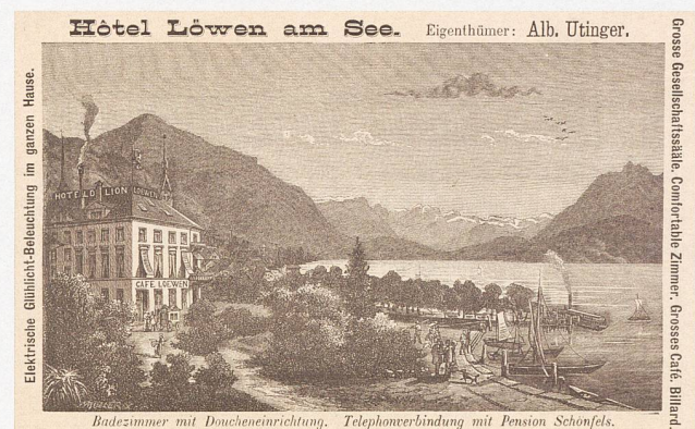
Abb. 1 Das Hotel Löwen besass 1885 als einzige Unterkunft im Kanton Zug eine elektrische Beleuchtung.
